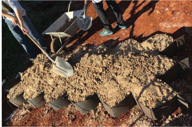
Figura 27 - Preenchimento da geocélula com resíduo.
