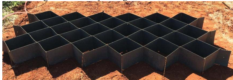
Figura 25 - Fixação da geocélula no terreno.
