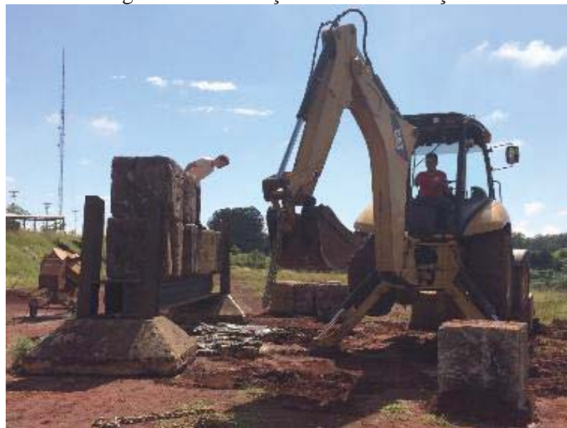
Figura 31 - Instalação sistema de reação.
