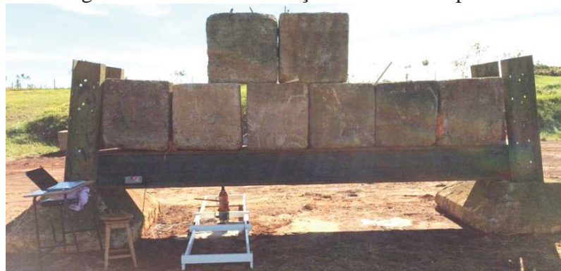
Figura 33 - Sistema de reação do ensaio de placa.
