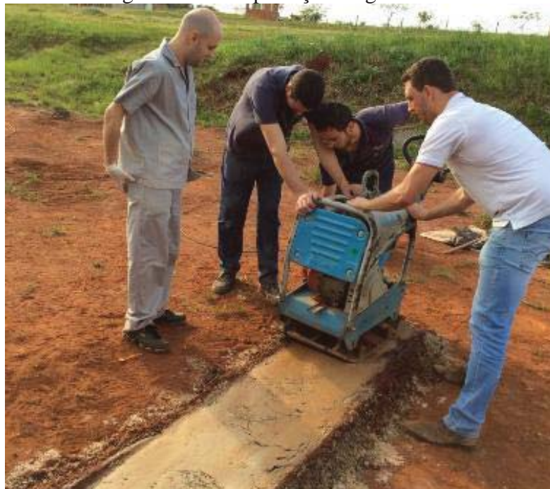
Figura 28 - Compactação da geocélula.
