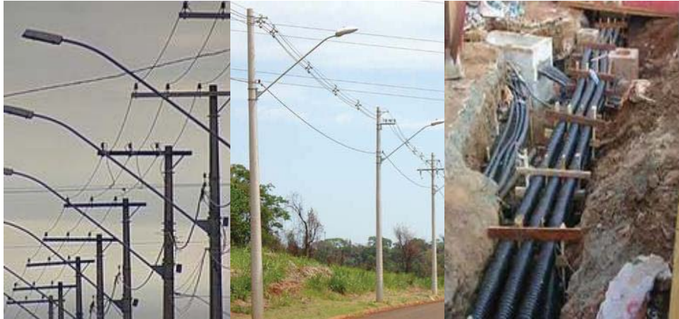
Figura 7: Exemplo de Rede Convencional, Compacta e Subterrânea
