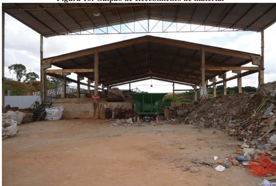
Figura 16: Galpão de Recebimento de material
