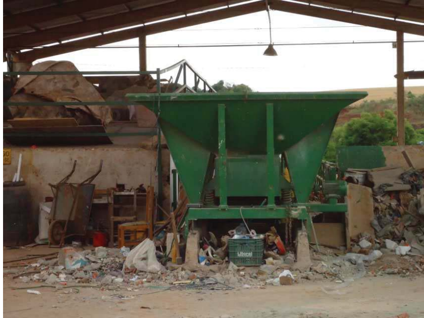
Figura 17: Galpão de Recebimento de material
