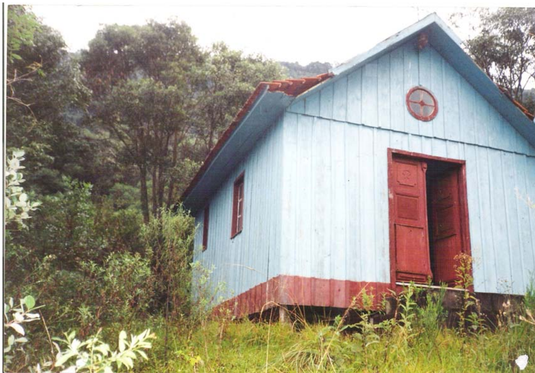
Figura 53: Registro do capitel, antes da reforma de 2003, sem data.
