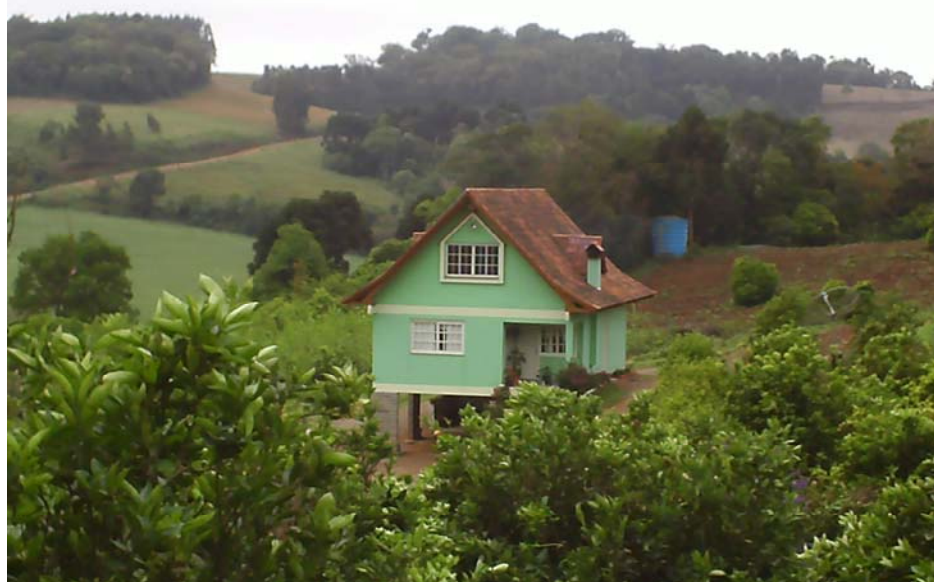
Figura 24: Casa do agricultor Alceu Primel na capela Santa Ana, em estilo montanhês. Fonte: Arquivo da autora, 2010
