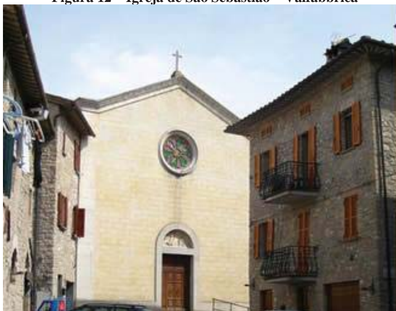
Figura 12 – Igreja de São Sebastião – Valfabbrica
