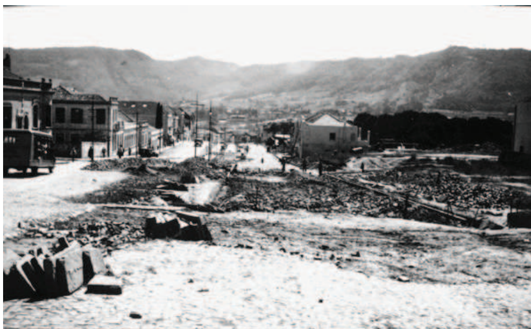
Figura 3: Obras da Avenida Rio Branco, esquina Dr. Daudt – Rebaixamento do “Boulevard” Central (1938) Fonte: Arquivo Histórico de Santa Maria.
