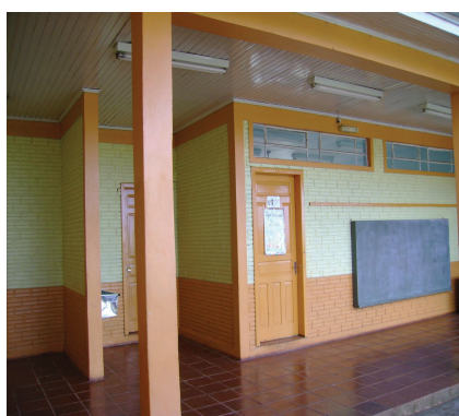
Vista do corredor da escola
