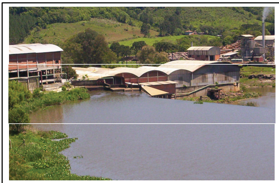
Figura 13 – Usina hidroelétrica própria ajudou no crescimento da empresa. (JAN., 2006). Fonte: foto do autor.
