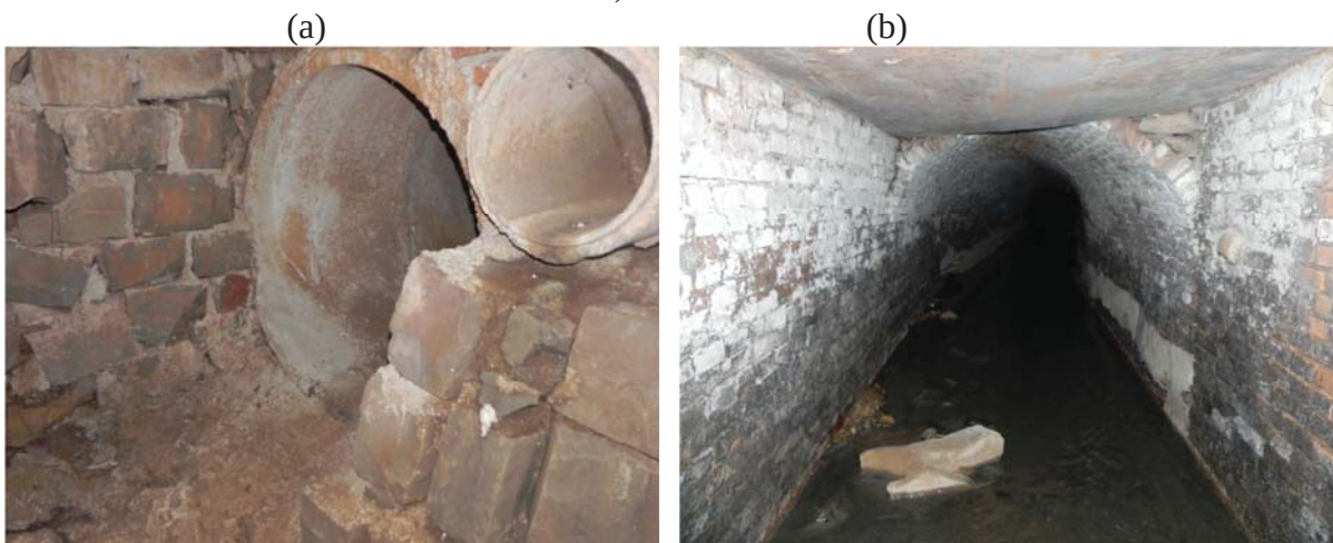
Figura 61 – (a) Ponto 8: chegada de tubulações contribuintes junto do passeio da Rua do Comércio; (b) Ponto 11, sob a rua do Comércio.
