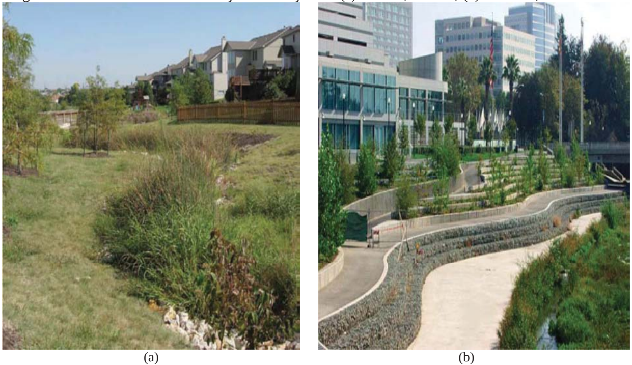
Figura 12 – Plano ou vala de infiltração e detenção em (a) Lenexa, Kansas; (b) San José, Califórnia.
