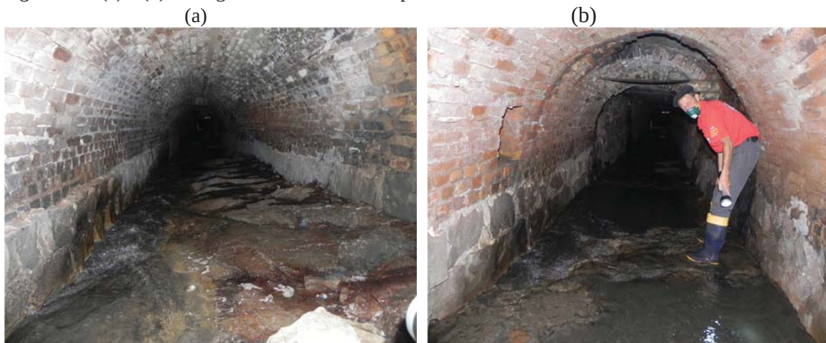
Figura 62 – (a) e (b) Passagem sob o mercado Super Central, identificado como Ponto 13.
