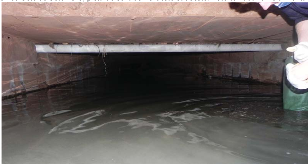
Figura 56 - Galeria do arroio Caramirim – ponto1, figura 53- rua Independência esquina com a avenida Sete de Setembro, pista do sentido nordeste-sudoeste. Foto tomada rumo a montante.
