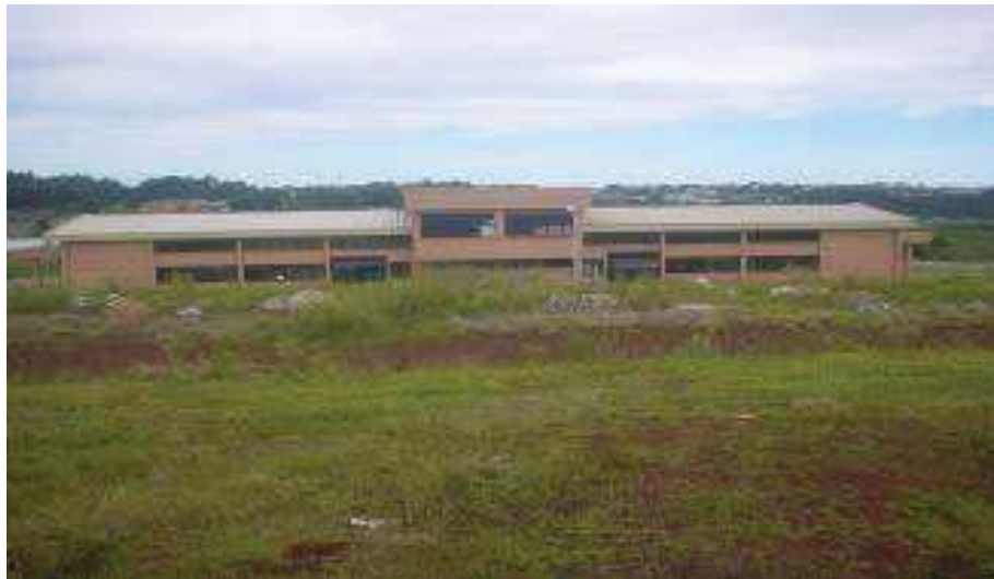
Figura 12: Campo experimental de geotecnia.
