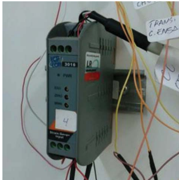
Figura 29: Condicionador de Sinal – SG 3016.
