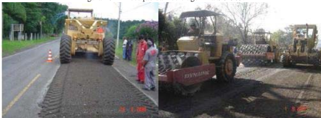
Figura 10 – Execução da Reciclagem na SC-303.
