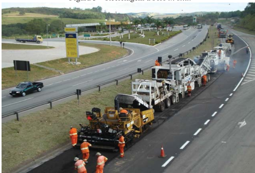
Figura 5 – Reciclagem a Frio in situ .
