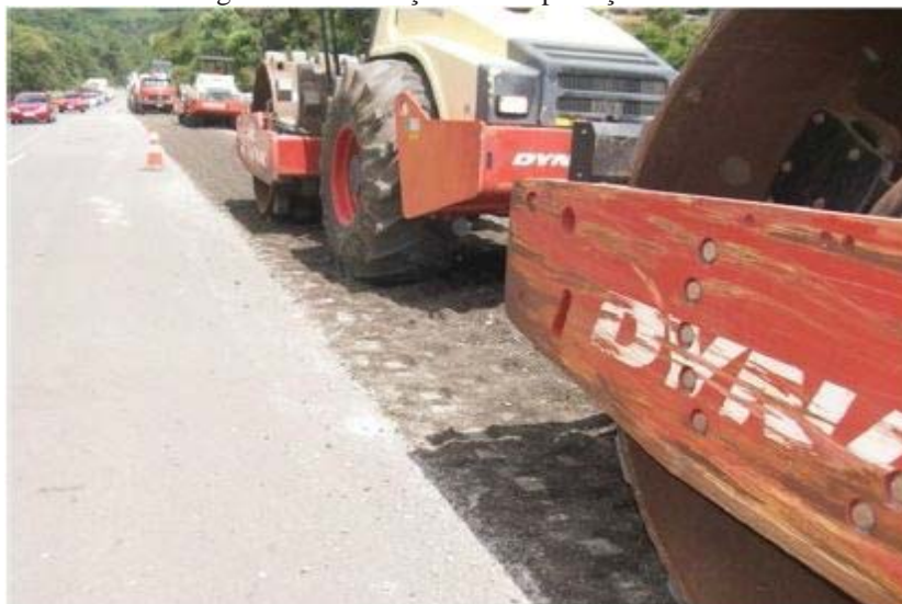
Figura 11 – Execução da compactação.
