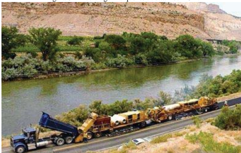
Figura 3 – Reciclagem a quente in situ nos EUA.
