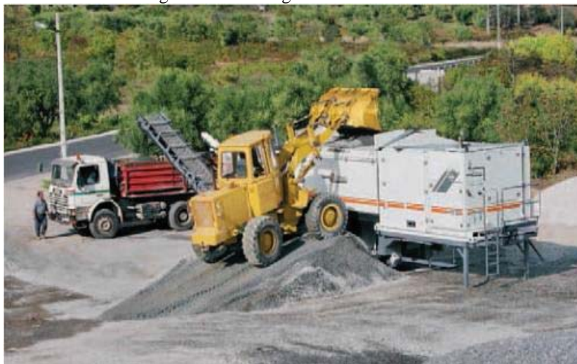
Figura 4 – Reciclagem a Frio em Usina.
