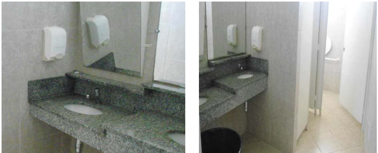
Figura 64: Banheiro masculino e banheiro feminino
