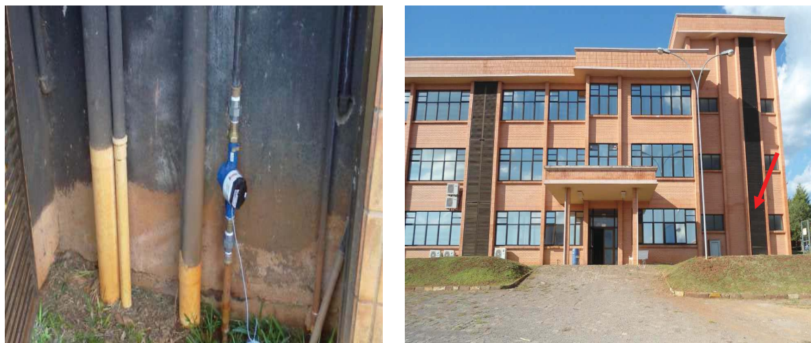
Figura 21: Local de instalação do hidrômetro no prédio do Curso de Farmácia.
