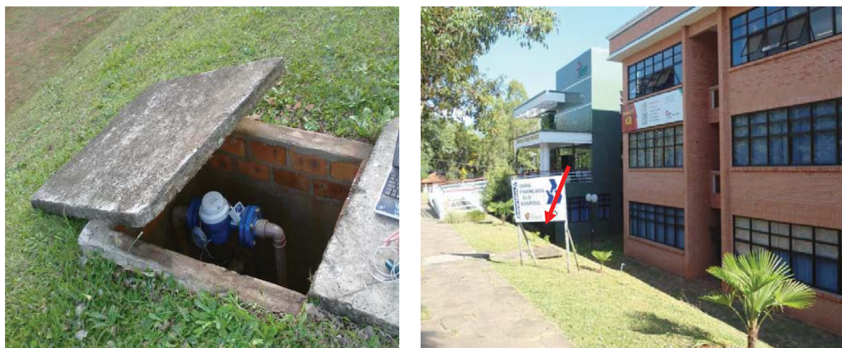
Figura 20: Local de instalação do hidrômetro no prédio do Instituto de Ciências Biológicas.
