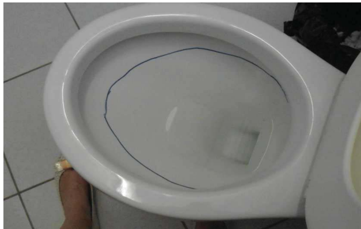
Figura 68: Bacia sanitária sem vazamento
