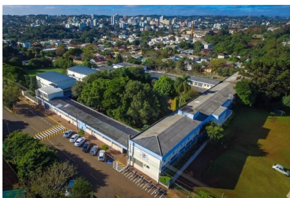
Figura 10 - Imagens aéreas da Escola Técnica Estadual 25 de Julho.
