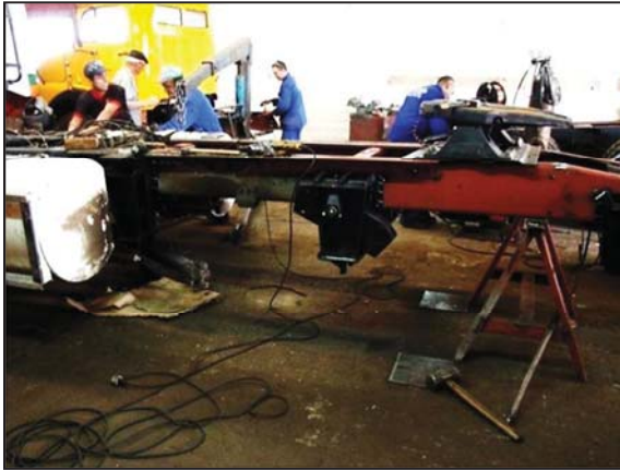
(a) Montagem instalação fabrica antiga
