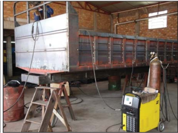
(b) Soldagem estrutural
