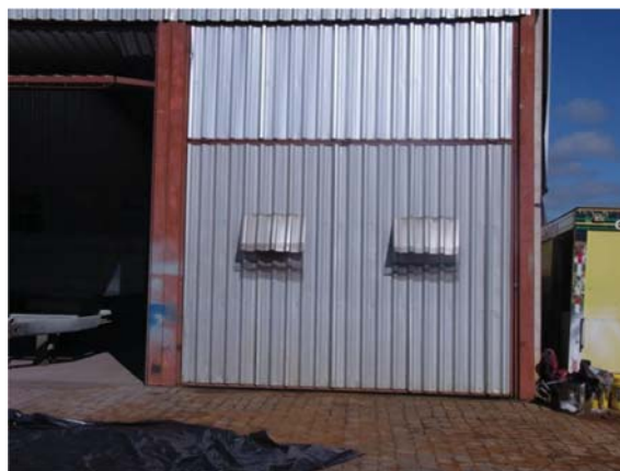
(b) Novas instalaões
