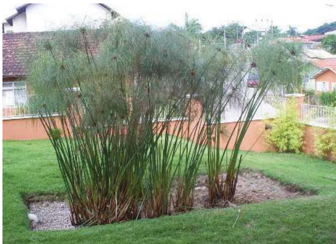
Figura 34: O sistema tratamento de esgoto por zona de raízes, implantado no empreendimento com a planta Cyperus papyrus .
