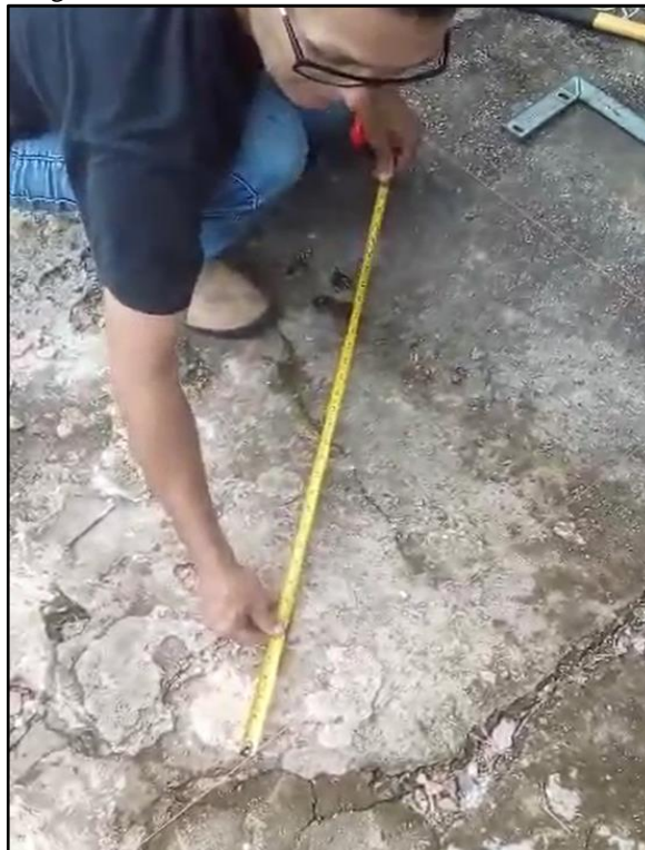
Figura 4 - Imagem do vídeo demonstrando o teorema de Pitágoras utilizado no assentamento de revestimento
