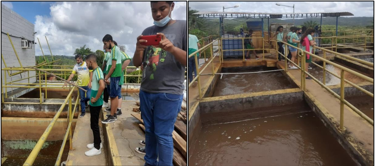
Figura 29 - Visita a ETA
