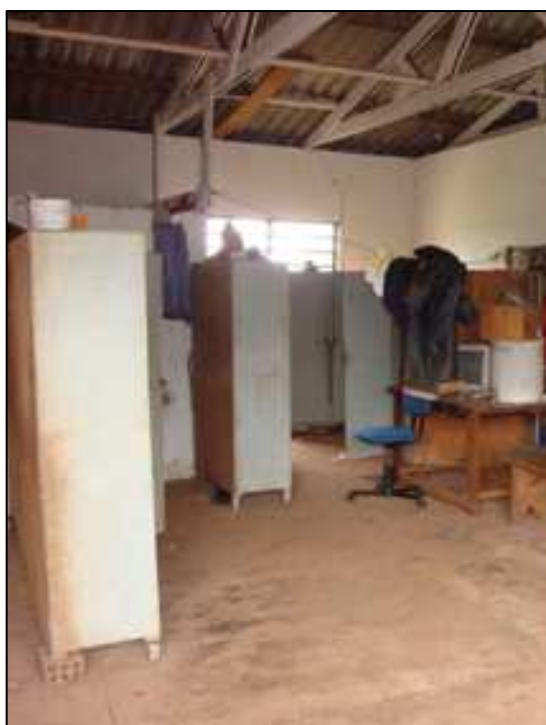
Figura 33: Vestiário masculino do prédio construído na área de disposição final de RSU do município
