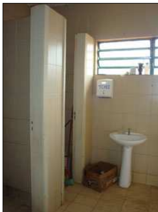
Figura 34: Banheiro feminino do prédio construído na área de disposição final de RSU do município
