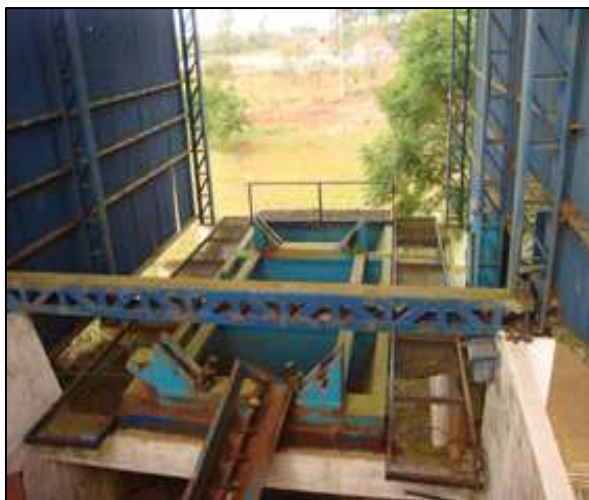
Figura 36: Equipamento para compostagem abandonado na área de disposição final de RSU do município
