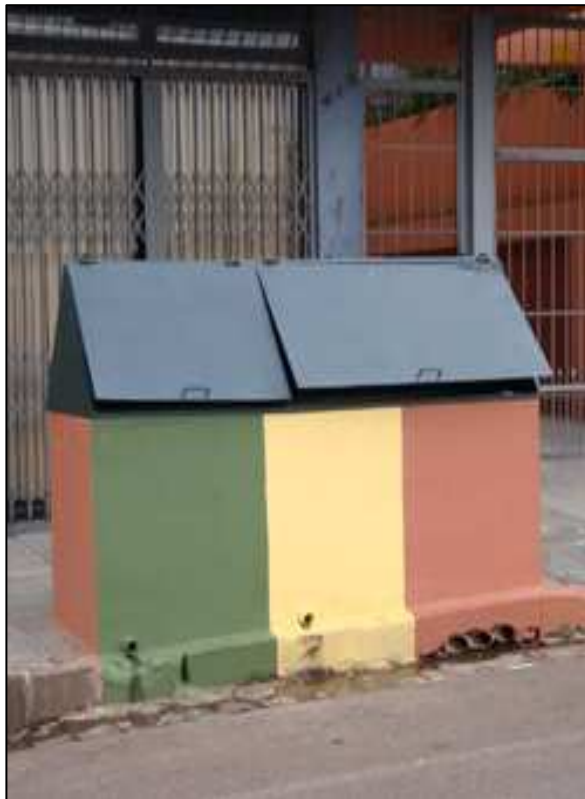
Figura 12: Recipiente de alvenaria utilizado para o acondicionamento de RSD
