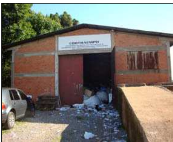
Figura 50: Galpão da COOTRAEMPO
