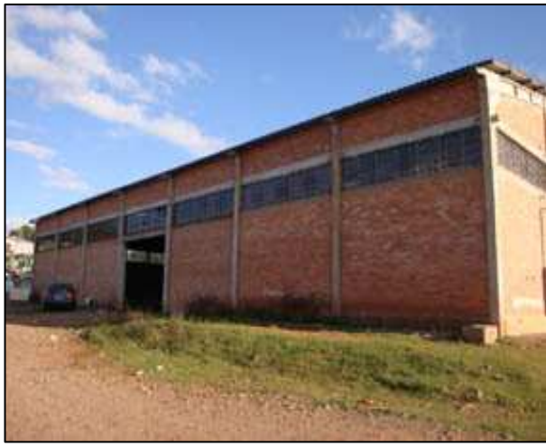
Figura 52: Galpão da AAMA
