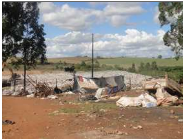
Figura 44: Barraco de catador construído sobre uma célula de aterro encerrada
