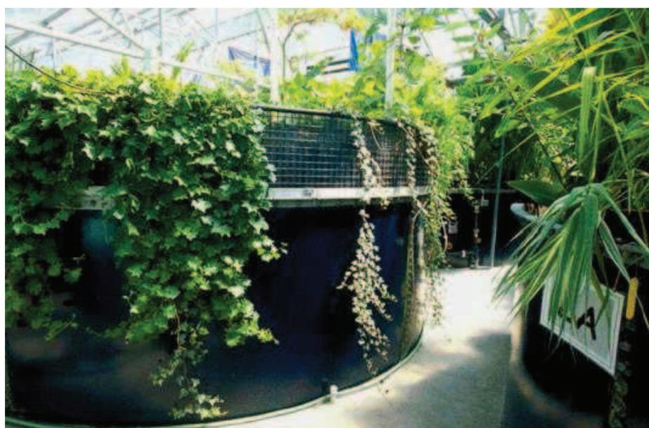
Figura 60: Tratamento de águas residuais e esgotos sanitário utilizando seqüência de tanques – Sistema Living Machine
