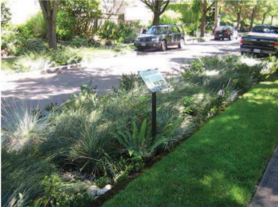
Figura 30: Espaço reservado na caixa de rua para os valos de infiltração
