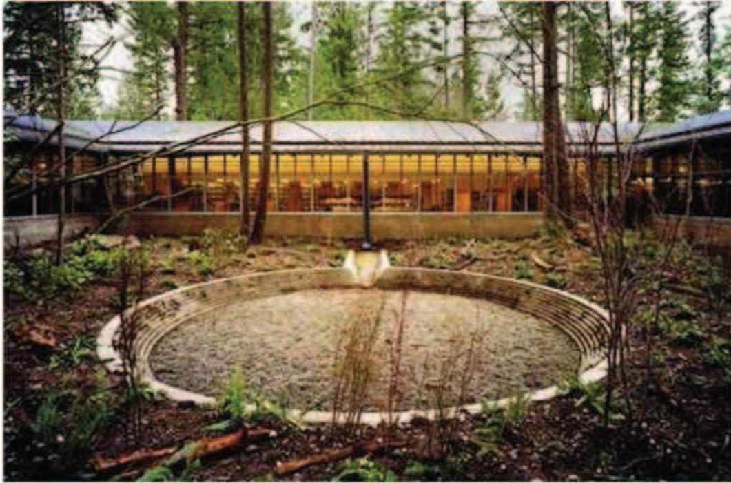
Figura 33: Trincheiras de infiltração inserido no projeto arquitetônico.
