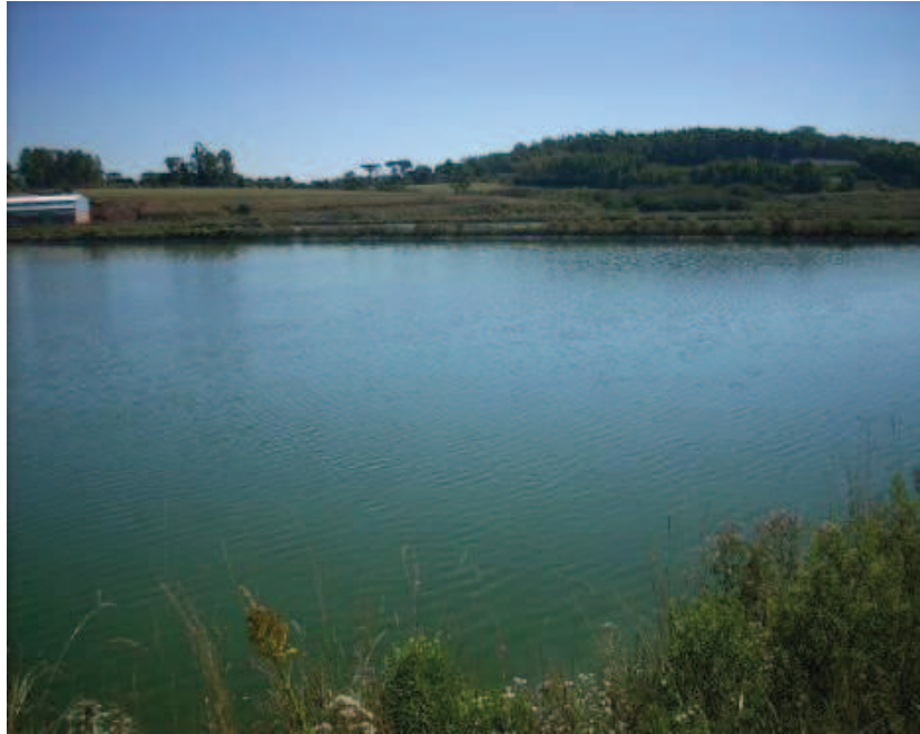
Figura 26: Lagoa Facultativa da ETE Araucárias.
