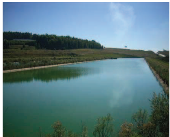
Figura 28: Segunda lagoa de Maturação da ETE Araucárias.
