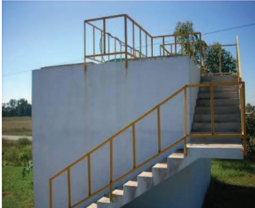
Figura 24: Chegada do esgoto na ETE Araucárias.
