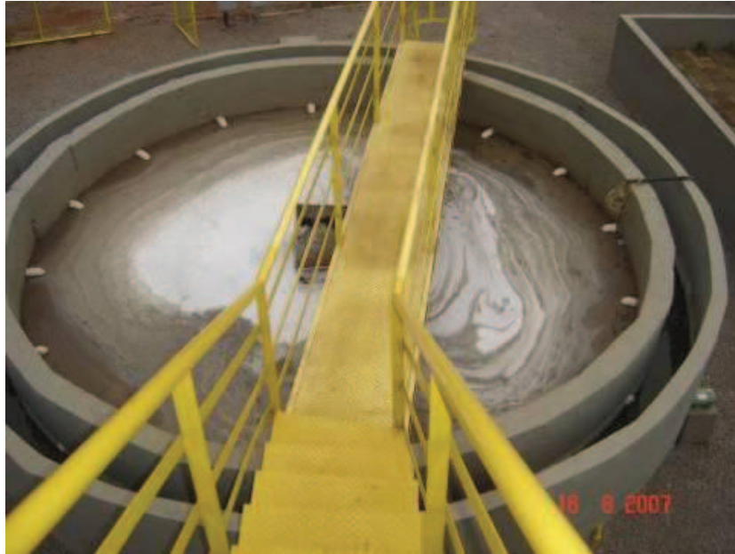
Figura 17: Tanque de acúmulo da ETE da UPF.
