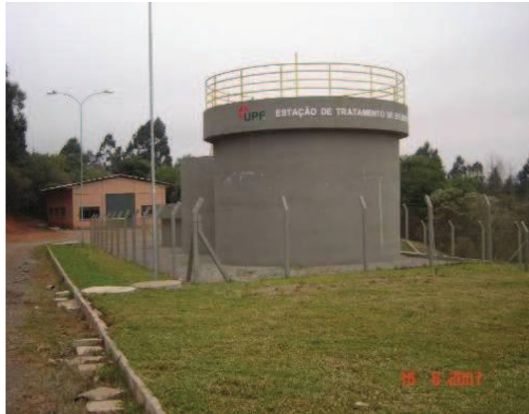
Figura 16: Estação de Tratamento de Esgoto do Campus I da Universidade de Passo Fundo.
