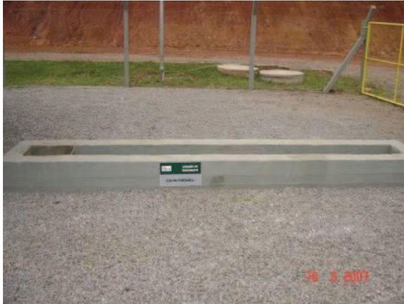
Figura 20: Calha Parshall da ETE da UPF.
