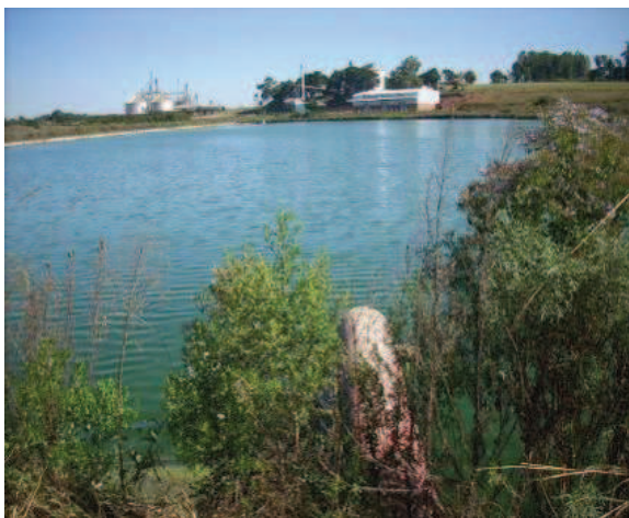
Figura 27: Primeira lagoa de Maturação da ETE Araucárias.
