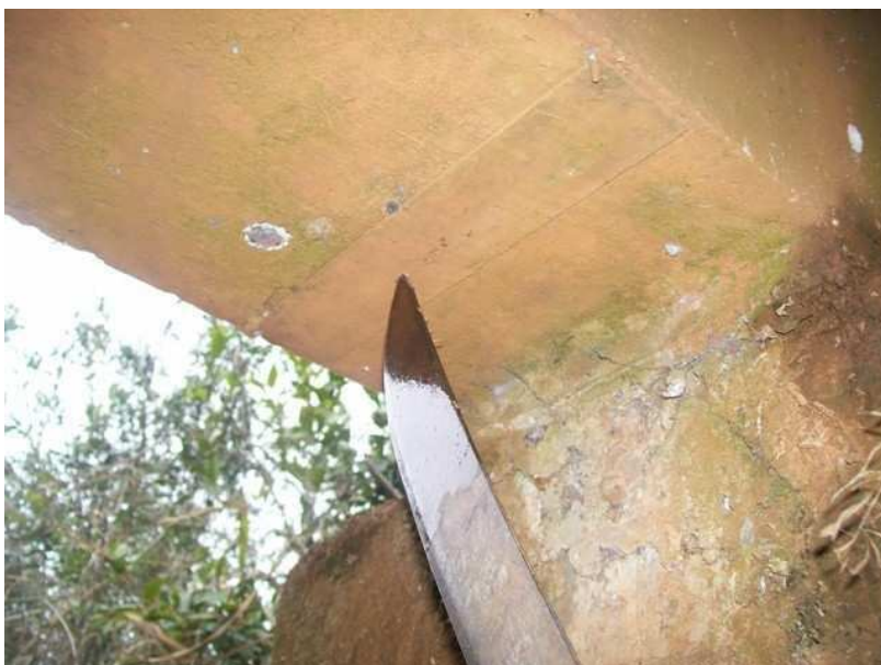
FIGURA 52 - Espaçador de sarrafo de madeira (Ponte P121)
