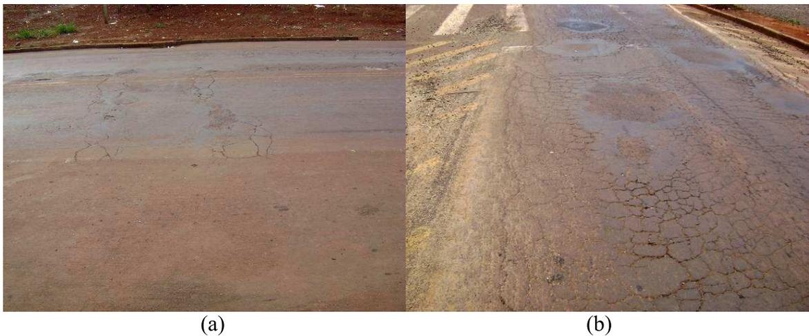
Figura 44 – Remendo de baixa severidade (a), presente na seção 9; e remendo de média severidade (b), presente na seção 12
