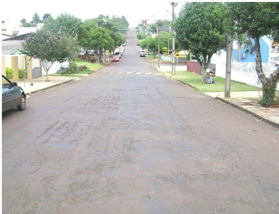
Figura 52 – Foto em primeiro plano da seção 8, classificação do pavimento PCI Regular
