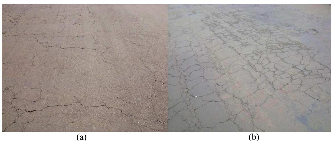
Figura 54 – Defeito couro de crocodilo de baixa severidade (a), presente na seção 1 e 2; e de média severidade (b), presente nas seções 13, 14 e 15
