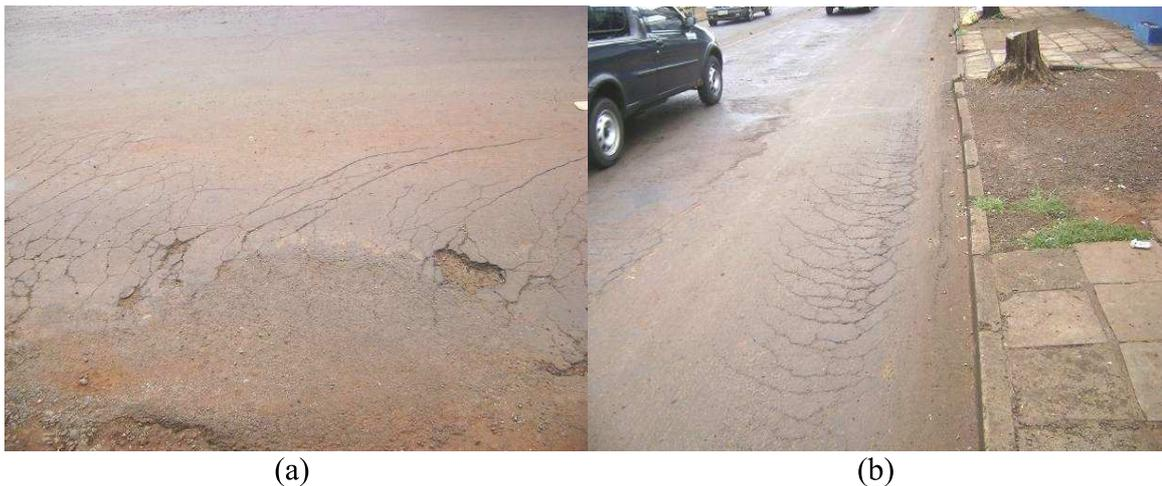
Figura 42 – Defeito escorregamento de massa de baixa severidade (a), presente na seção 5; e de média severidade (b), presente na seção 3
