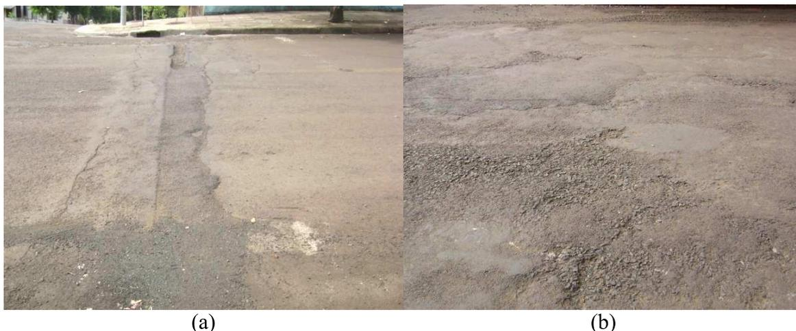
Figura 58– Remendo de média severidade (a), presente na seção 6; e remendo de baixa severidade (b), presente no trecho 19
