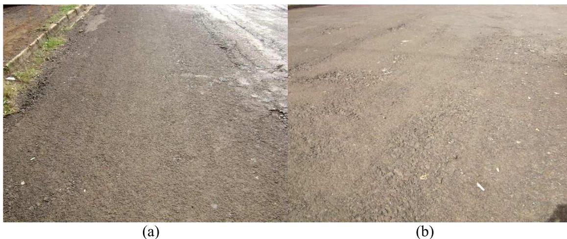
Figura 62 – Desgaste de média severidade (a), presente na seção 10; e alta severidade (b), presente na seção 4
