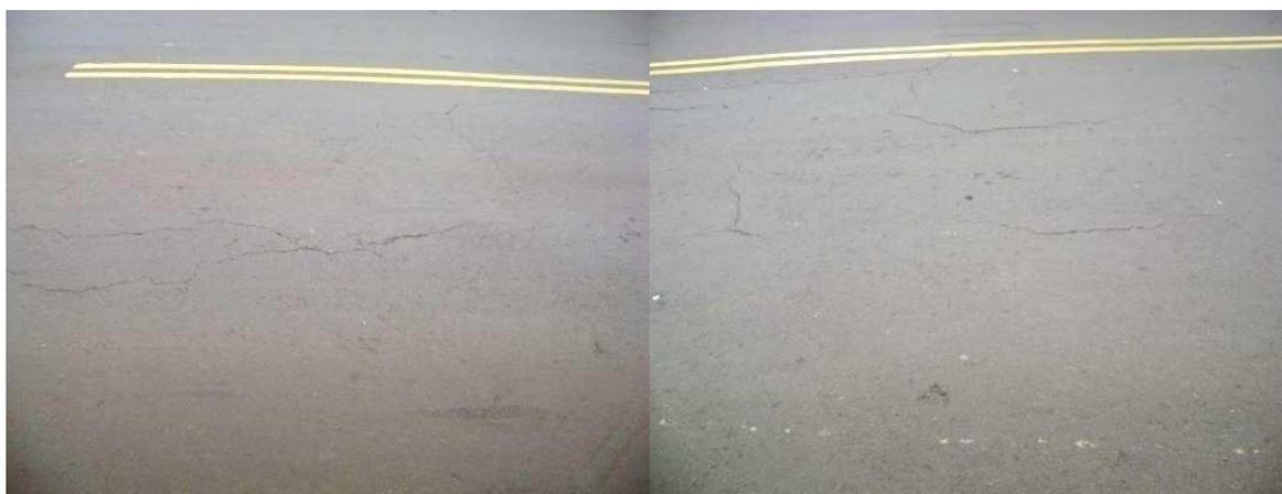
Figura 56 – Defeito fissuras em bloco de baixa severidade, presente na seção 1
