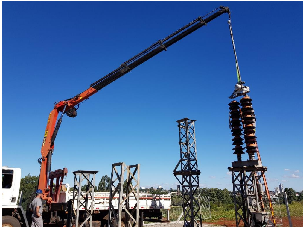
Figura 14 – Montagem da chave seccionadora BMKU - 40A
