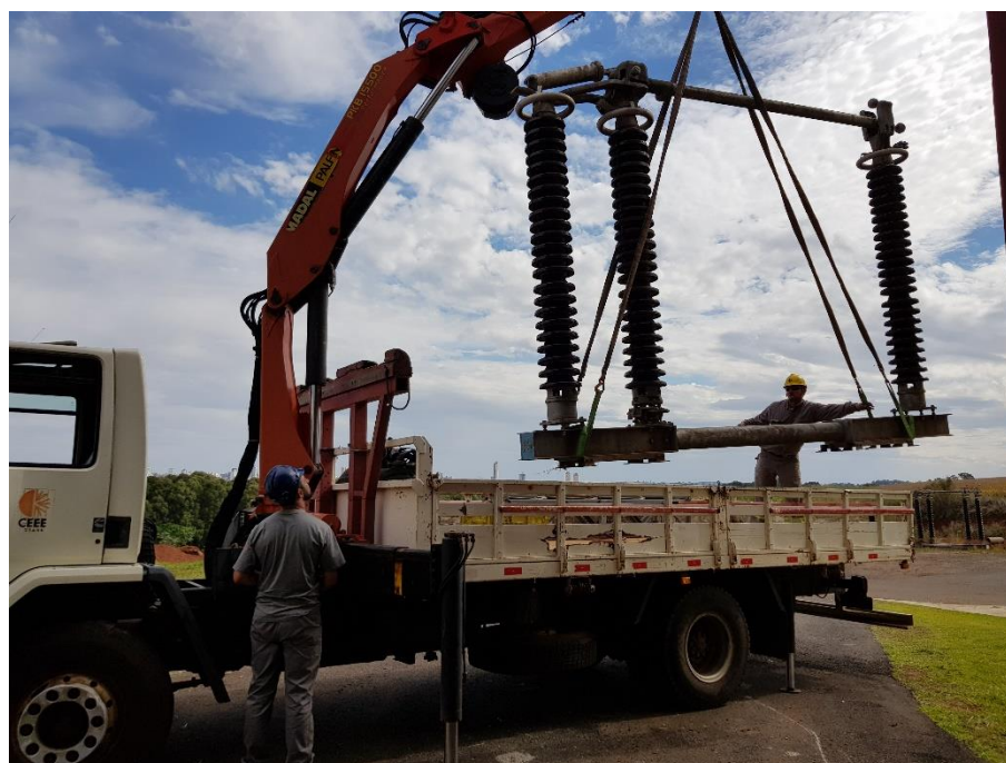
Figura 15 – Montagem chave seccionadora Lorenzetti 242 kV
