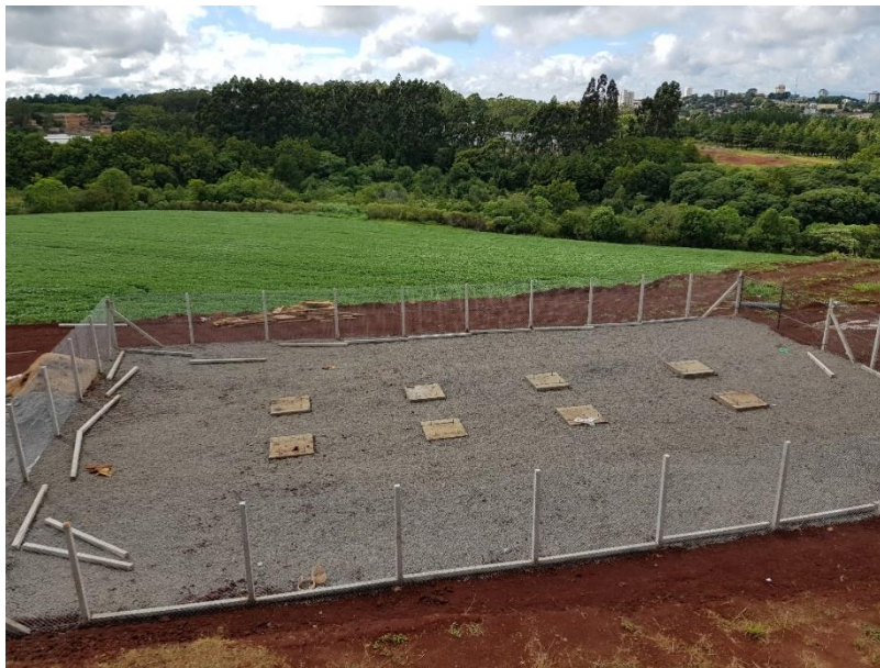
Figura 10 – Fundações da bancada de testes
