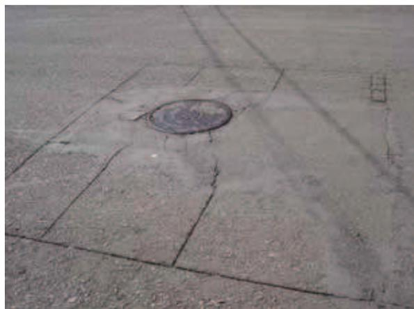
Figura 207: tampa demarcando passagem da canalização
