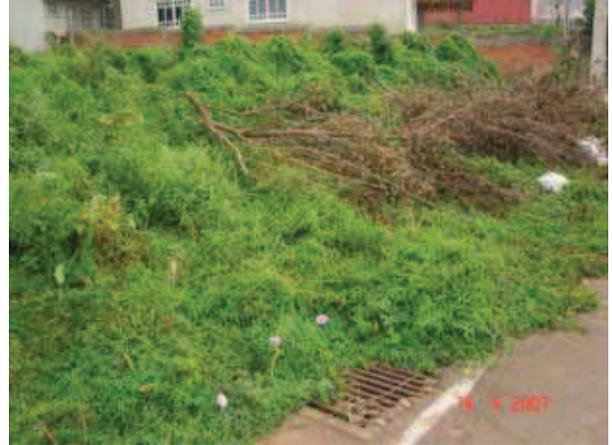
Figura 104: boca-de-lobo mal localizada e parcialmente coberta pela vegetação
