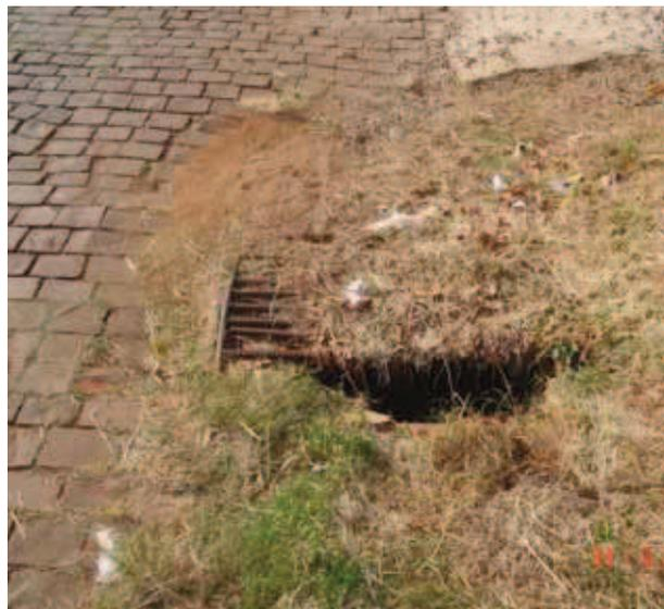
Figura 47: boca-de-lobo que mistura a canalização da sanga com as águas pluviais, em péssimo estado de conservação
