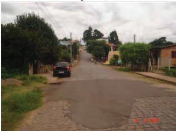
Figura 115: local da passagem da canalização, onde se percebe pavimentação diferenciada
