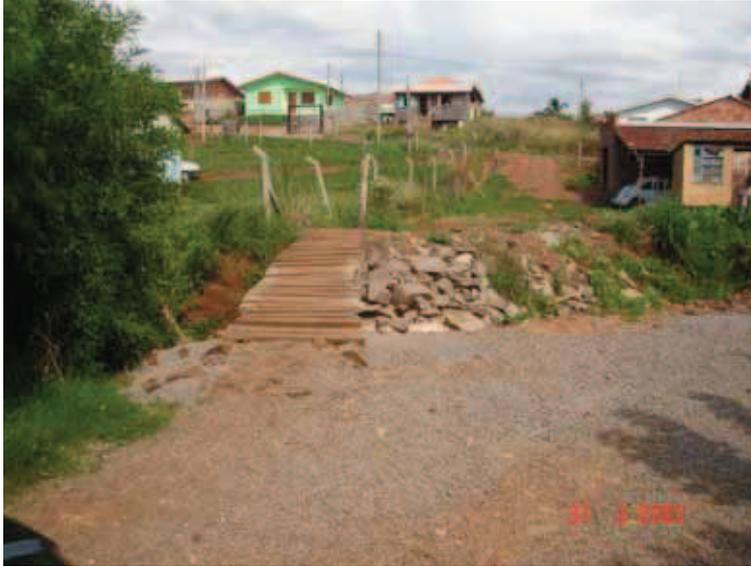
Figura 62: em estado precário, passagem para pedestres sobre o córrego
