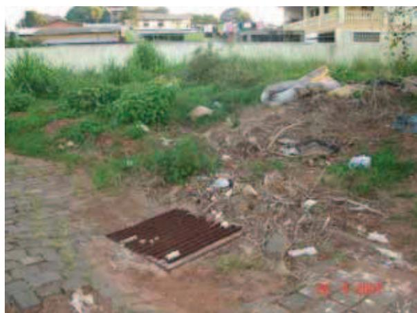
Figura 147: boca-de-lobo vertical nos fundos de terreno baldio
