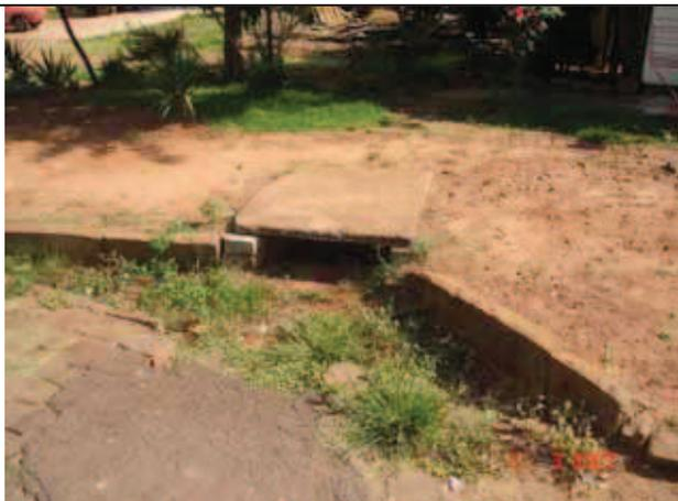
Figura 55: boca-de-lobo com captação lateral
