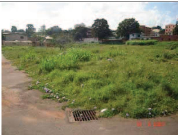
Figura 53: boca-de-lobo mal posicionada
