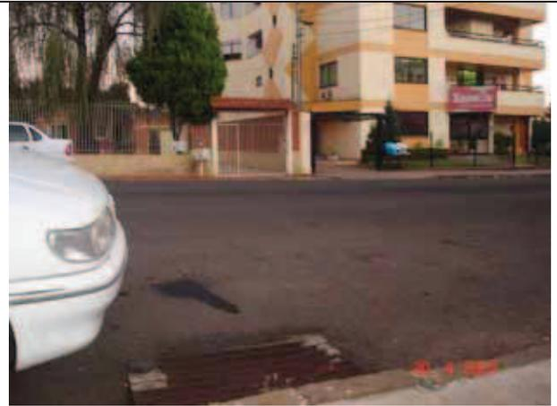
Figura 141: canalização de sanga juntamente com boca-de-lobo
