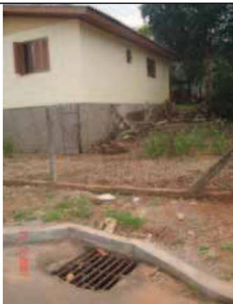
Figura 68: meio-fio e pavimentação da rua com reentrância para incorporar caixa de coleta
