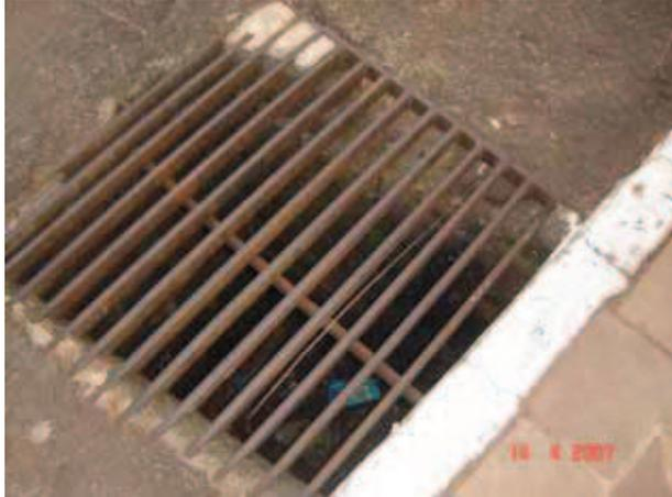
Figura 84: Boca-de-lobo de sistema vertical
