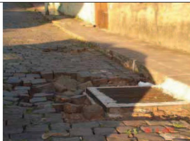
Figura 137: boca-de-lobo com provável vazamento, danificando a pavimentação de paralelepípedos
