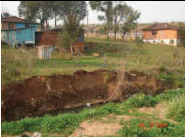
Figura 248: processo erosivo junto ao leito do curso d'água
