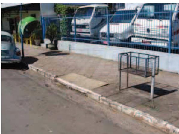
Figura 214: tampas das caixas de passagem da canalização
