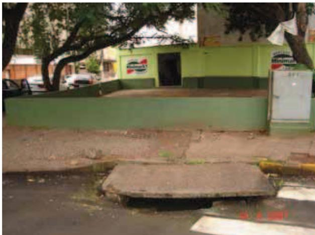
Figura 78: início do canal da Brahma, marcado por caixa onde passa a canalização
