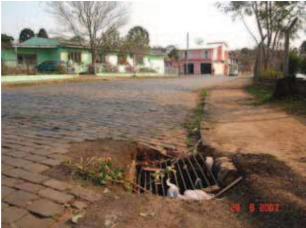
Figura 226: boca-de-lobo mal localizada e em péssimo estado de conservação
