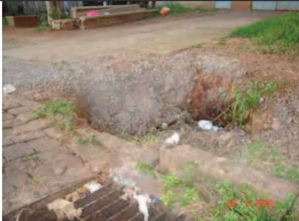
Figura 132: desmoronamento do solo ao lado da galeria
