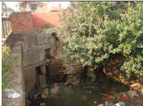
Figura 237: lançamento de esgoto no rio
