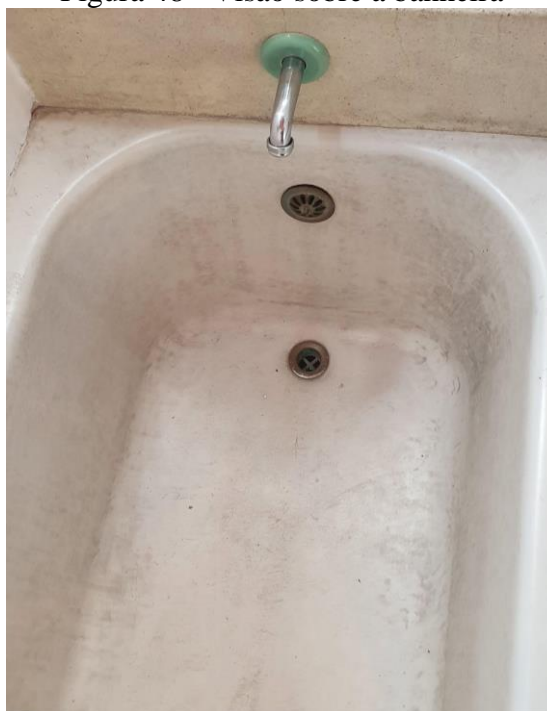
Figura 48 - Visão sobre a banheira
