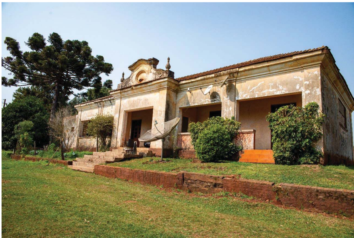
Figura 24 – Estrutura predial da antiga EEPF em 2021
