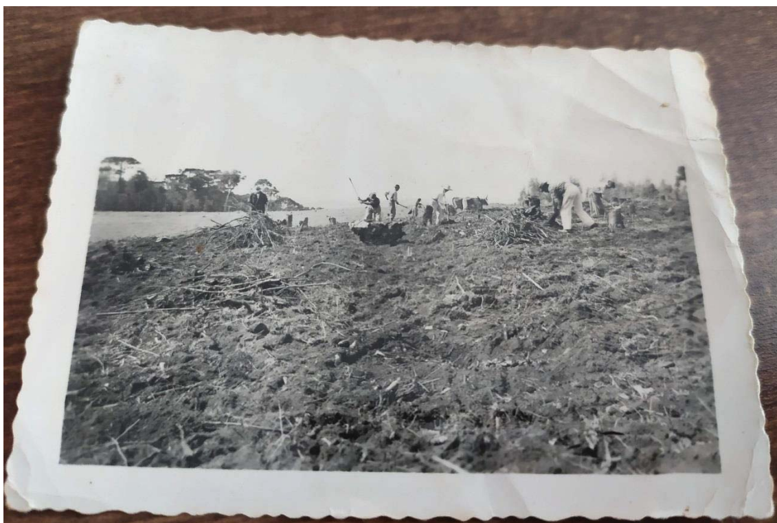
Figura 9 - Trabalhos de destocamento na área da EEPF em Vila Englert.
