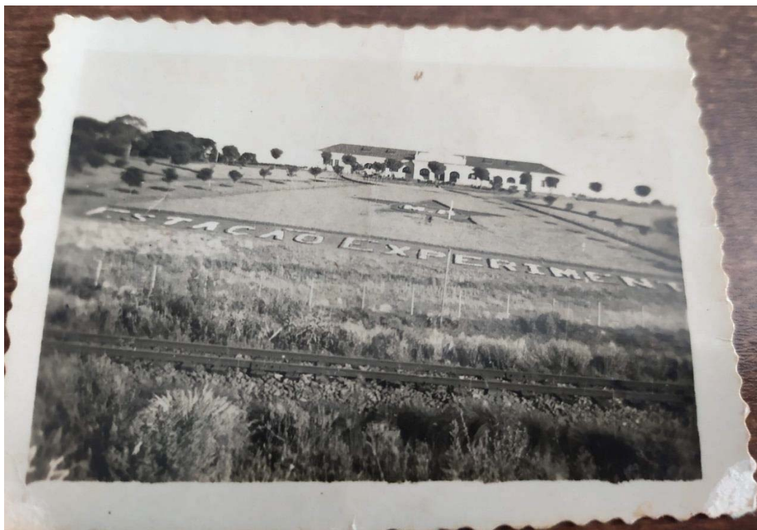
Figura 13 - Prédio principal da Estação Experimental de Passo Fundo inaugurada em novembro de 1940.
