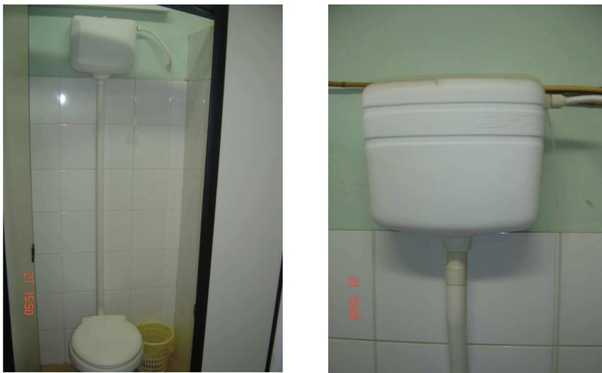
**Figura 40 – Caixa de descarga de sobrepor e sistema de bacia sanitária**
