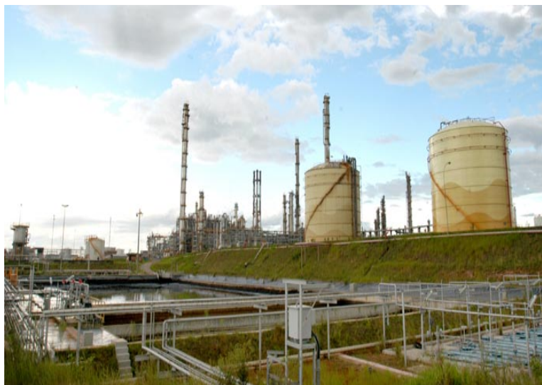
Figura 20 – Sistema de Pré-Tratamento do Efluente Orgânico.
