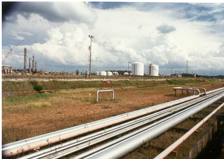
Figura 13 – Tubovias entre as empresas do Pólo Petroquímico do Sul.
