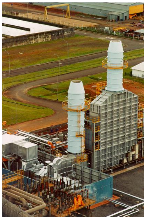
Figura 32 – Turbina a Gás Utilizada pela Empresa.
