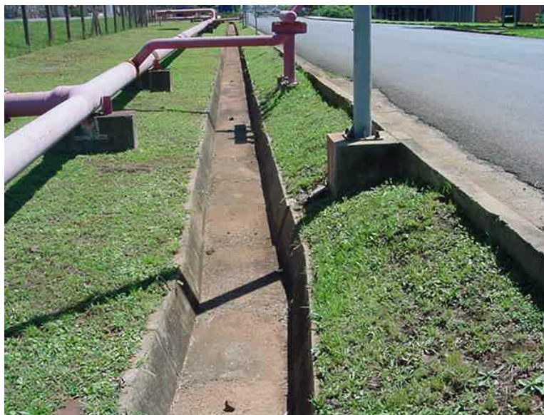
Figura 19 – Canaletas de Coleta de Efluente Pluvial do Pátio Administrativo.
