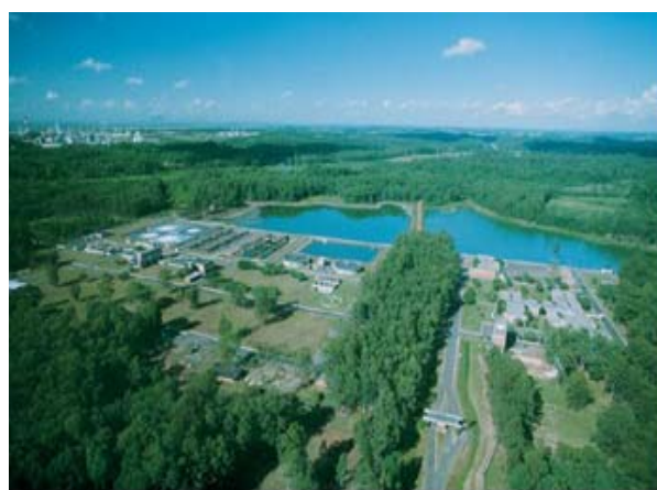
Figura 23 – Vista Geral das Oito Lagoas de Estabilização do Sistema de Tratamento Terciário de Efluentes, antes da Disposição Final no Solo.
