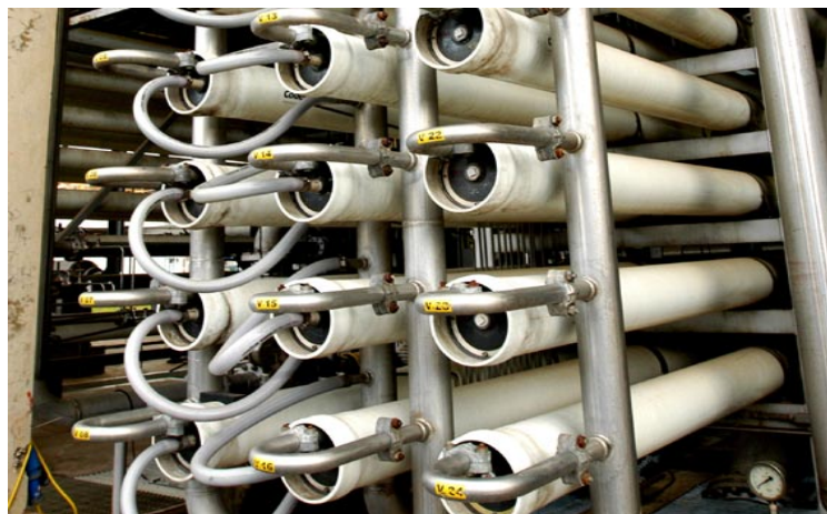
Figura 31 - Unidade de Osmose Reversa, para a Desmineralização da Água
