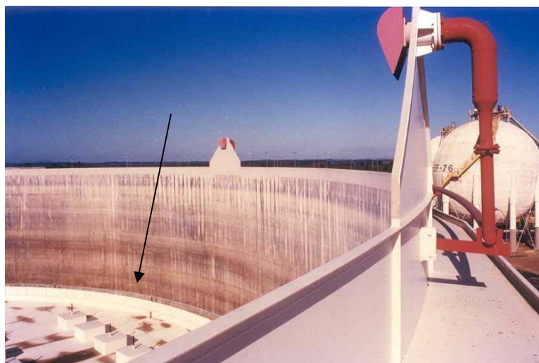
Figura 16 – Teto Flutuante Utilizado nas Zonas Armazenadoras do Produto.
