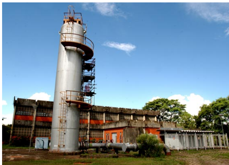
Figura 30 – Estação de Captação e Tratamento da Água na Empresa.
