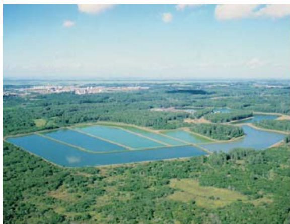
Figura 22 – Unidade de Tratamento Primário, Secundário e Terciário dos Efluentes.
