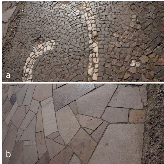
Figura 59 - Pavimentação de pedra portuguesa (a) e basalto (b)
