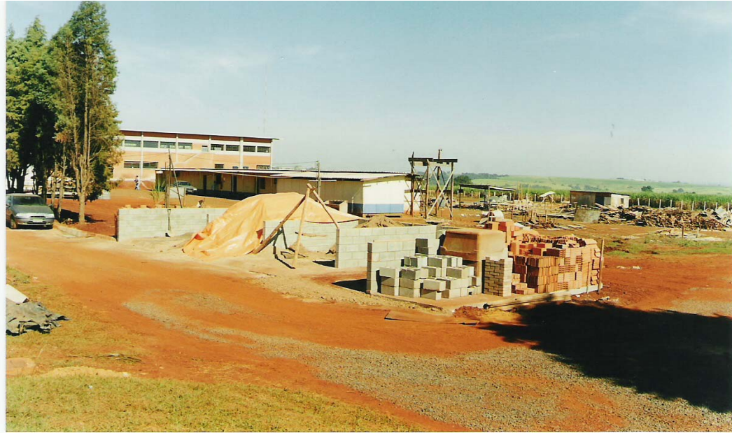
Figura 43 - Área destinada a canteiro de obras e depósito de materiais – Unimep.
