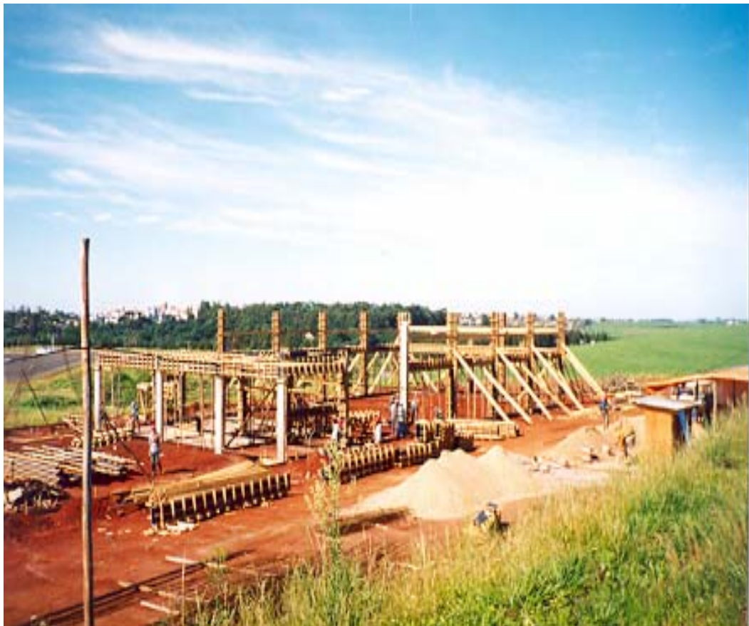
Figura 5 – Detalhes do primeiro prédio do CETEC (fevereiro de 2004)
