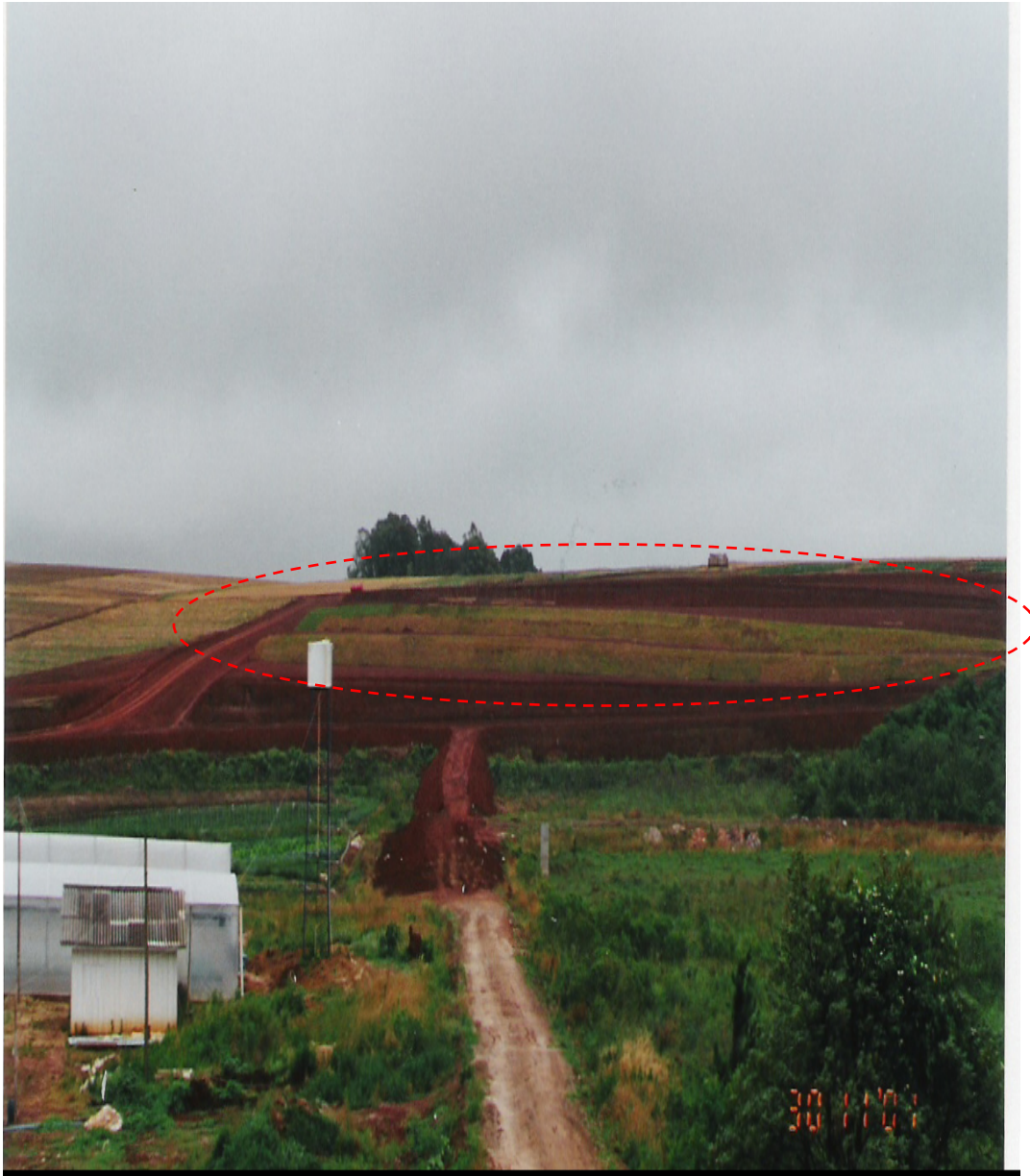
Figura 56 – Terreno após os serviços de terraplenagem.
