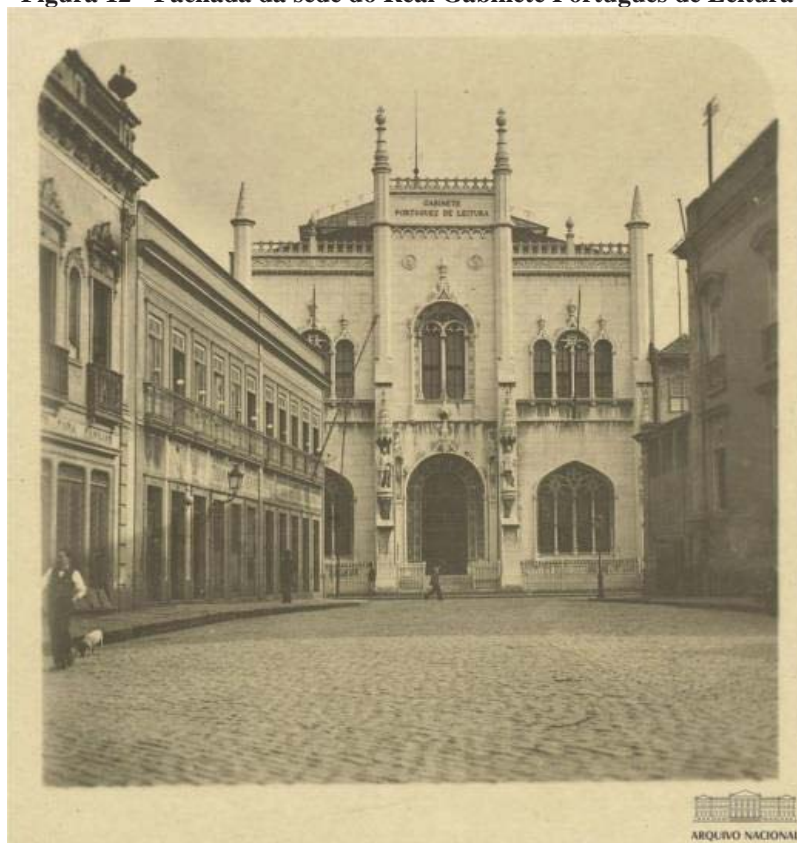
Figura 12 - Fachada da sede do Real Gabinete Português de Leitura
