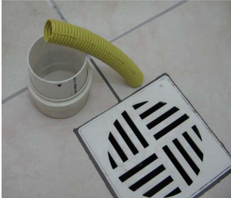
Figura 30: Tubo flexível para a coleta nos lavatórios.
