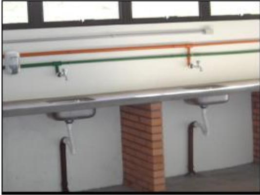
Figura 49: Tubulação diferenciada dos dois tipos de sistema de água nos laboratórios do CETEC.
