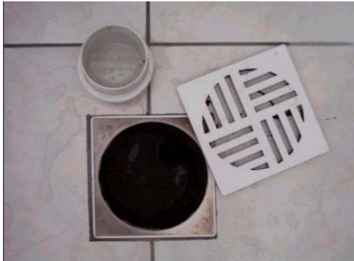
Figura 29: Coletor e caixa sifonada de um banheiro analisado.
