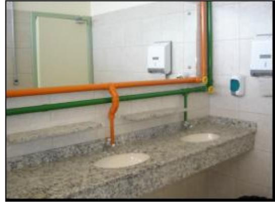
Figura 50: Tubulação diferenciada para os dois sistemas de água no banheiro do CETEC.
