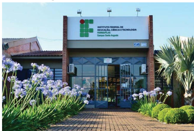
Figura 4 – Fachada do IFFar-SA
