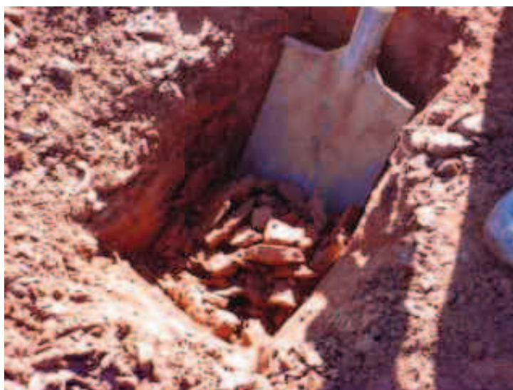
Figura 3.17 – Solo da área de aterro.
