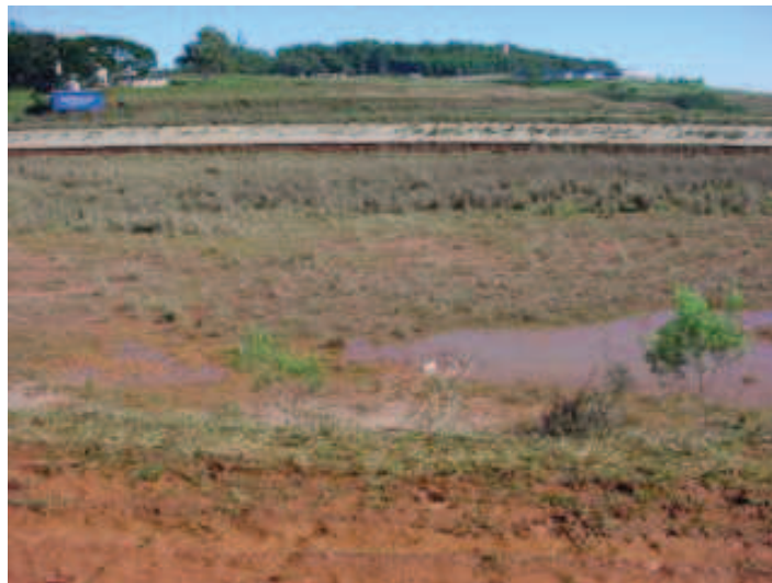
Figura 3.9– Área de corte da Lagoa Anaeróbia
