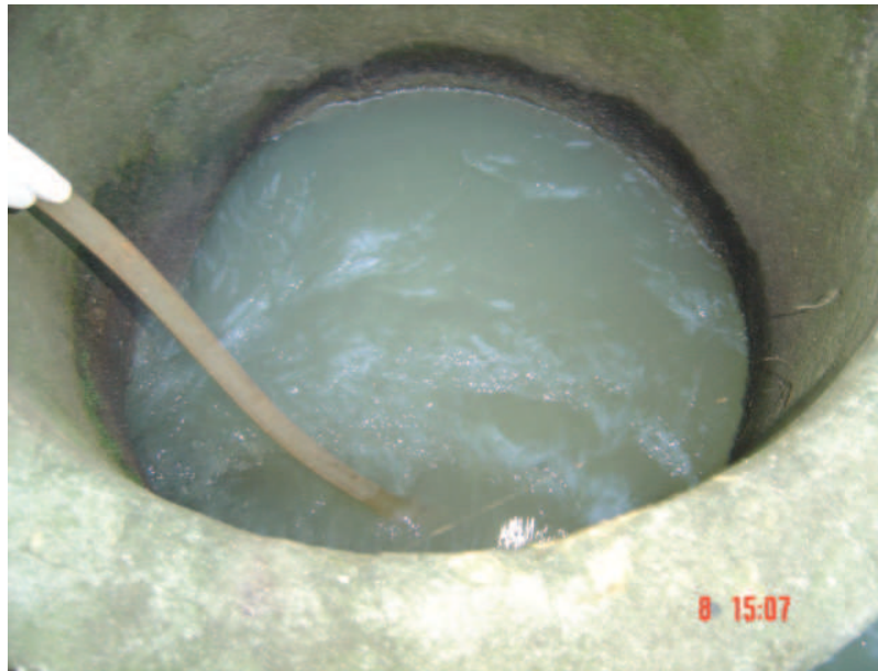
Figura 3.30 – Coleta do esgoto para o equipamento de colmatação.
