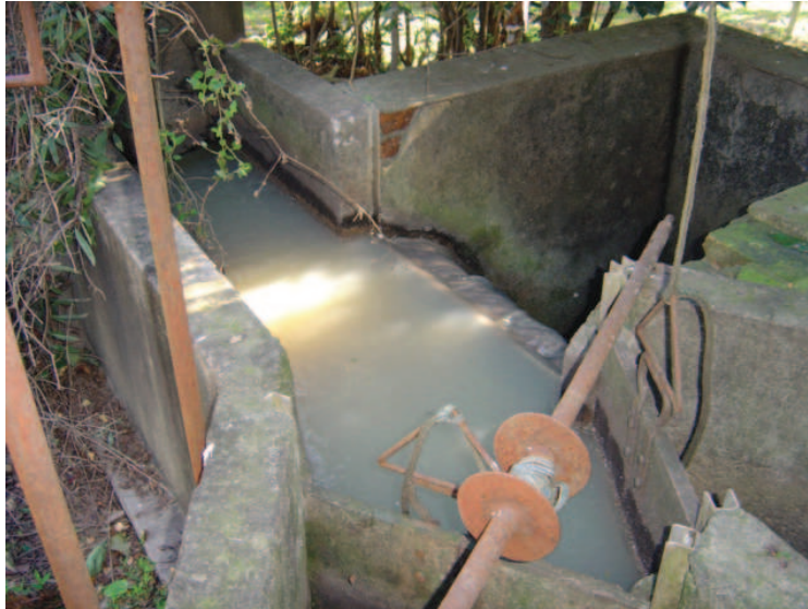
Figura 3.13 – Local de coleta do esgoto na Antiga ETE de Passo Fundo.
