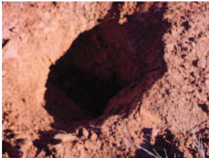
Figura 3.15 – Vala para coleta do solo da área de aterro.
