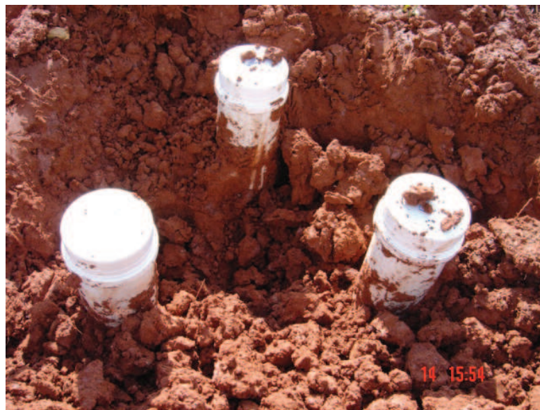
Figura 3.25 – Escavação para a retirada dos tubos para coleta das amostras indeformadas para o equipamento de colmatação.
