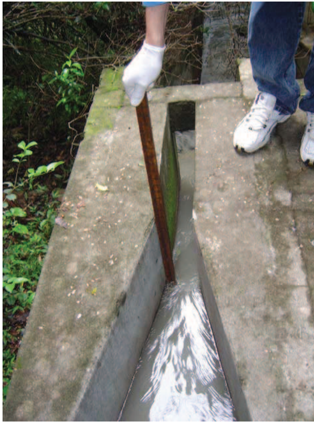
Figura 3.28 – Medição da Vazão na calha Parshal.
