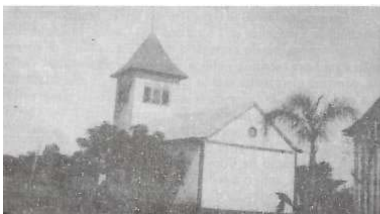
Figura 36 - Igreja de Lagoa dos Três Cantos.
