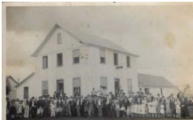
Figura 56 - Edificação Comercial em Sede Aurora-Cruz Alta, década de 30/40.
