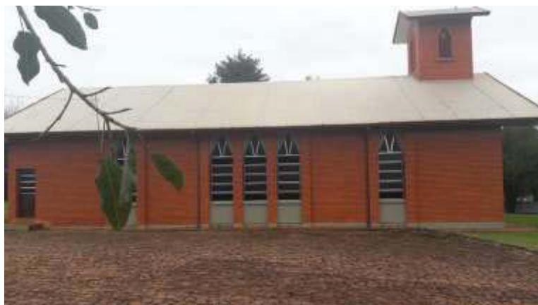
Figura 84 – Fachada lateral da igreja de Coronel Gervásio.
