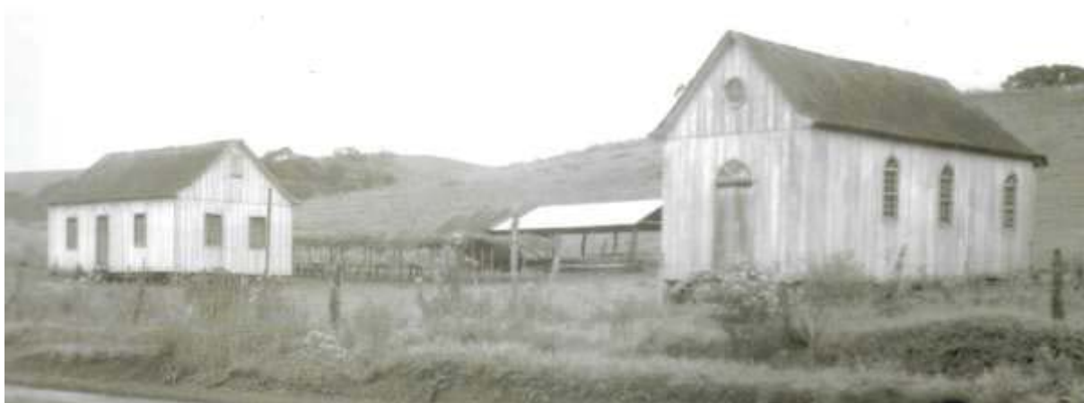
Figura 57 - Capela construída por volta de 1960.
