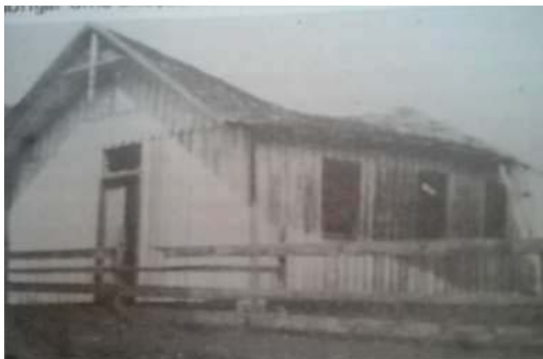
Figura 31 - Igreja de Tapera, construída entre 1911 e 1913.
