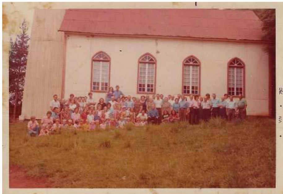
Figura 62 - Imagem igreja de Linha Kronenthal. Construção em enxaimel.
