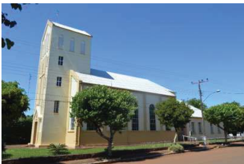
Figura 82 – Fachada lateral da igreja de Lagoa dos Três Cantos.
