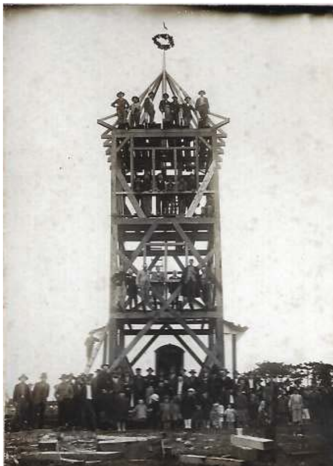
Figura 37 - Construção da torre da Igreja de Lagoa dos Três Cantos.
