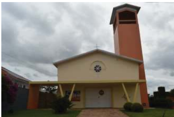
Figura 75 – Fachada frontal da igreja de Tapera.
