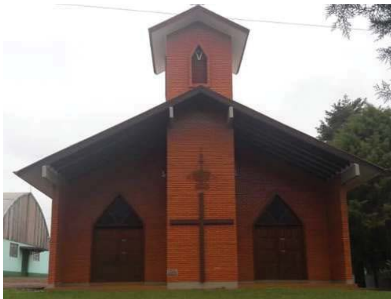
Figura 83 – Fachada frontal da igreja de Coronel Gervásio.
