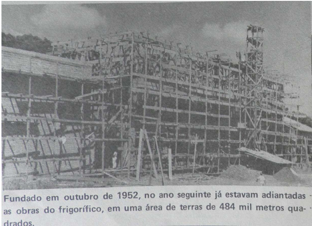
Figura 6: Construção das instalações da S.A. Indústria e Comércio Chapecó, em 1952
