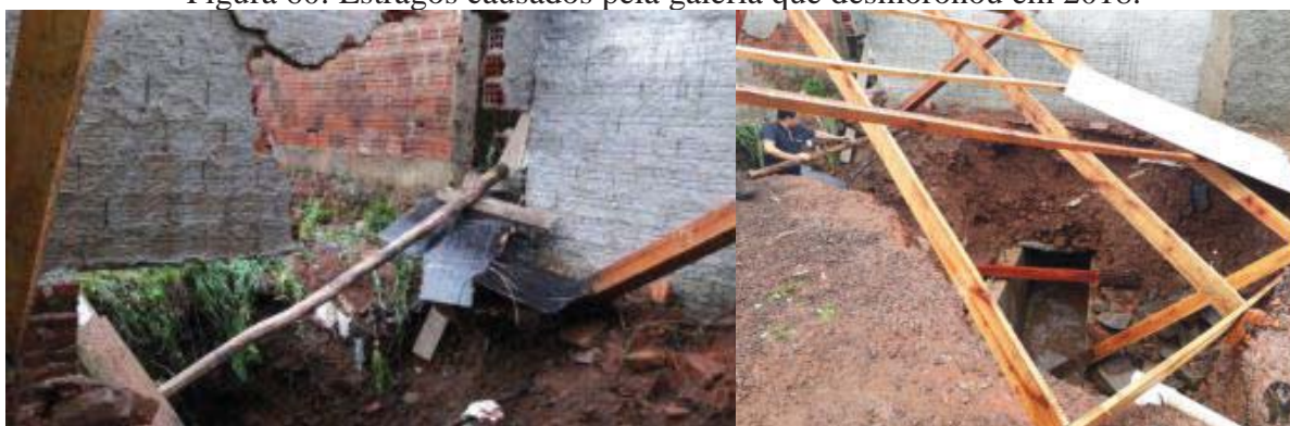
Figura 60: Estragos causados pela galeria que desmoronou em 2018.
