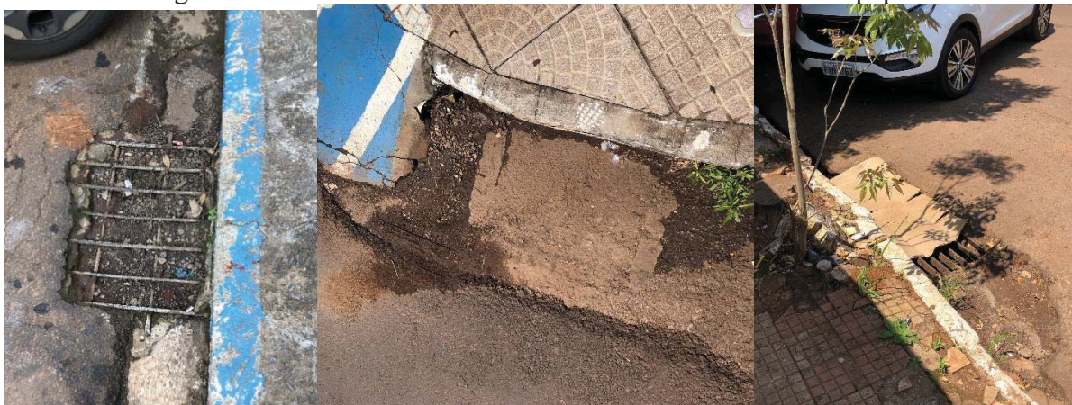
Figura 61: Bocas de lobo concretadas e boca de cobertura com papelão
