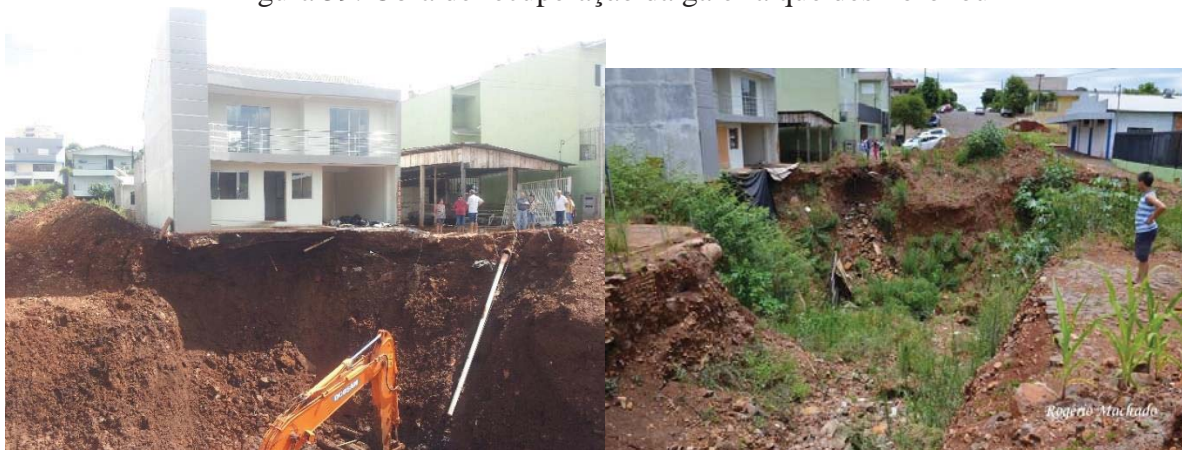
Figura 59: Obra de recuperação da galeria que desmoronou
