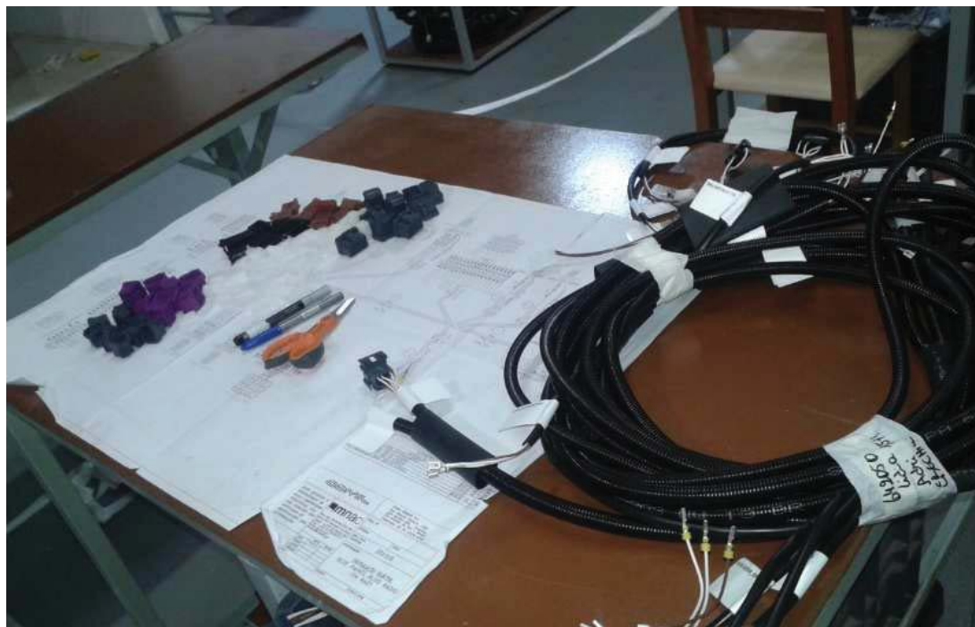
Figura 33 – Mesa de conexão (setor de crimpagem)
