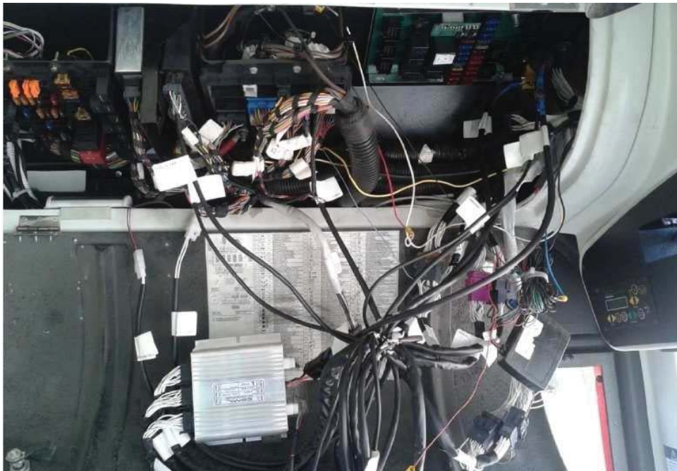
Figura 4: Procedimento de troca da central elétrica pelo multiplex.
