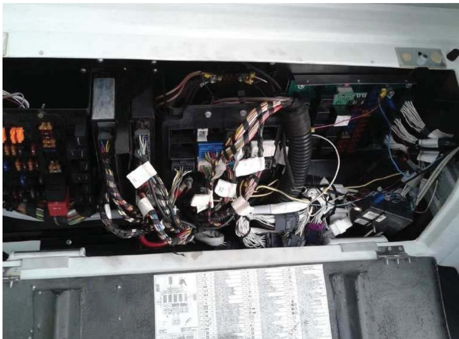
Figura 1: Central eléctrica antes da intervenção.
