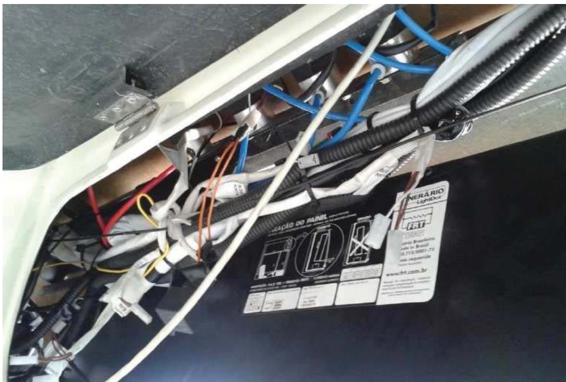
figura 8: intervenção anterior no sistema do bloqueador de portas
