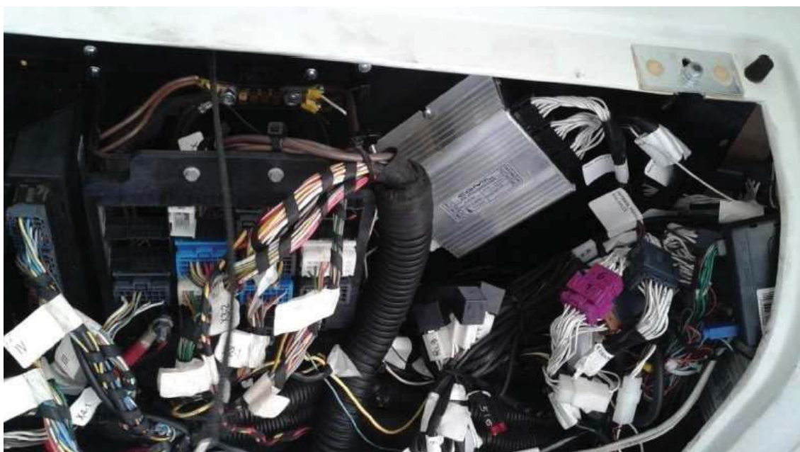
Figura 6: Central elétrica após a intervenção
