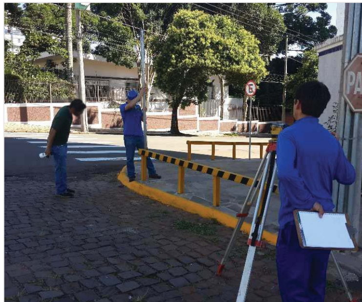
Figura 40 – Nivelamento geométrico duplo.
