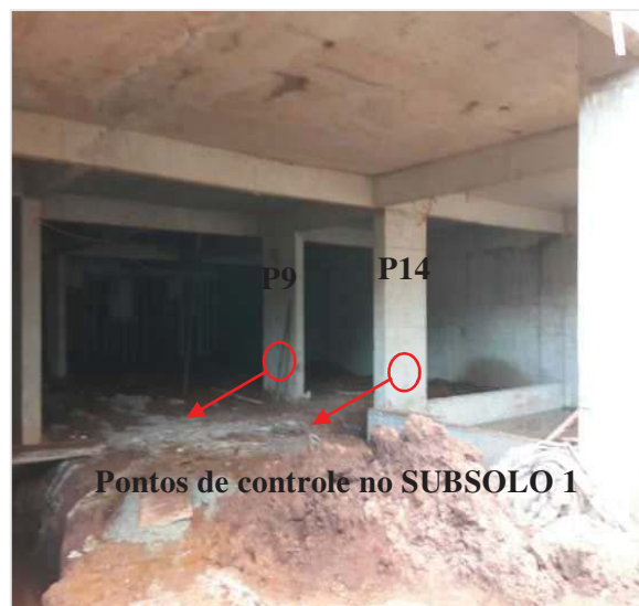
Figura 41 – Identificação dos pontos de controle no subsolo 1.
