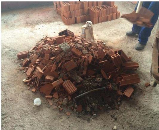
(b) transporte de resíduos cerâmicos, segregados manualmente do pavimento 10
