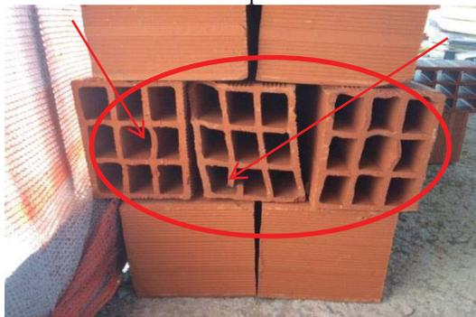
(g) Movimentação de tijolos no pavimento com transporte inadequado
