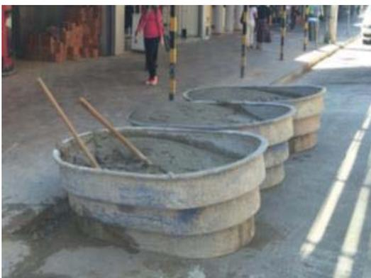
(b) Transporte da argamassa do pavimento térreo para o pavimento de execução de alvenaria
