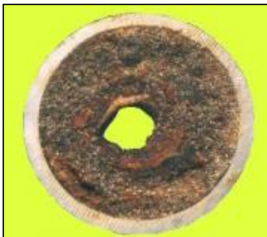
Figura 1 - Entupimento causado por deposição de orgânicos pesados .
