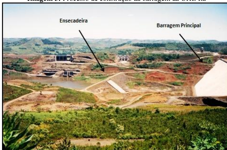
Imagem 5: Processo de construção da barragem da UHE Itá
